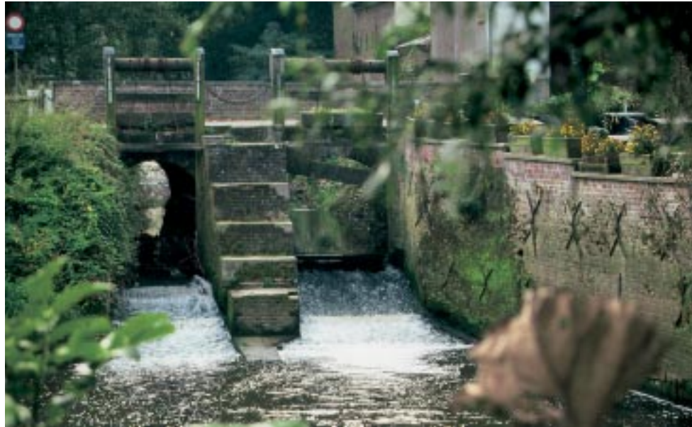
Door het plaatsen van stuwen is het oorspronkelijke stromingspatroon met snel en traag stromende zones veranderd in een egaal stromingspatroon. Bovendien vormen de stuwen barrières voor vissen en andere watergebonden organismen (foto: de klepstuw van de Ter Biestmolen).
