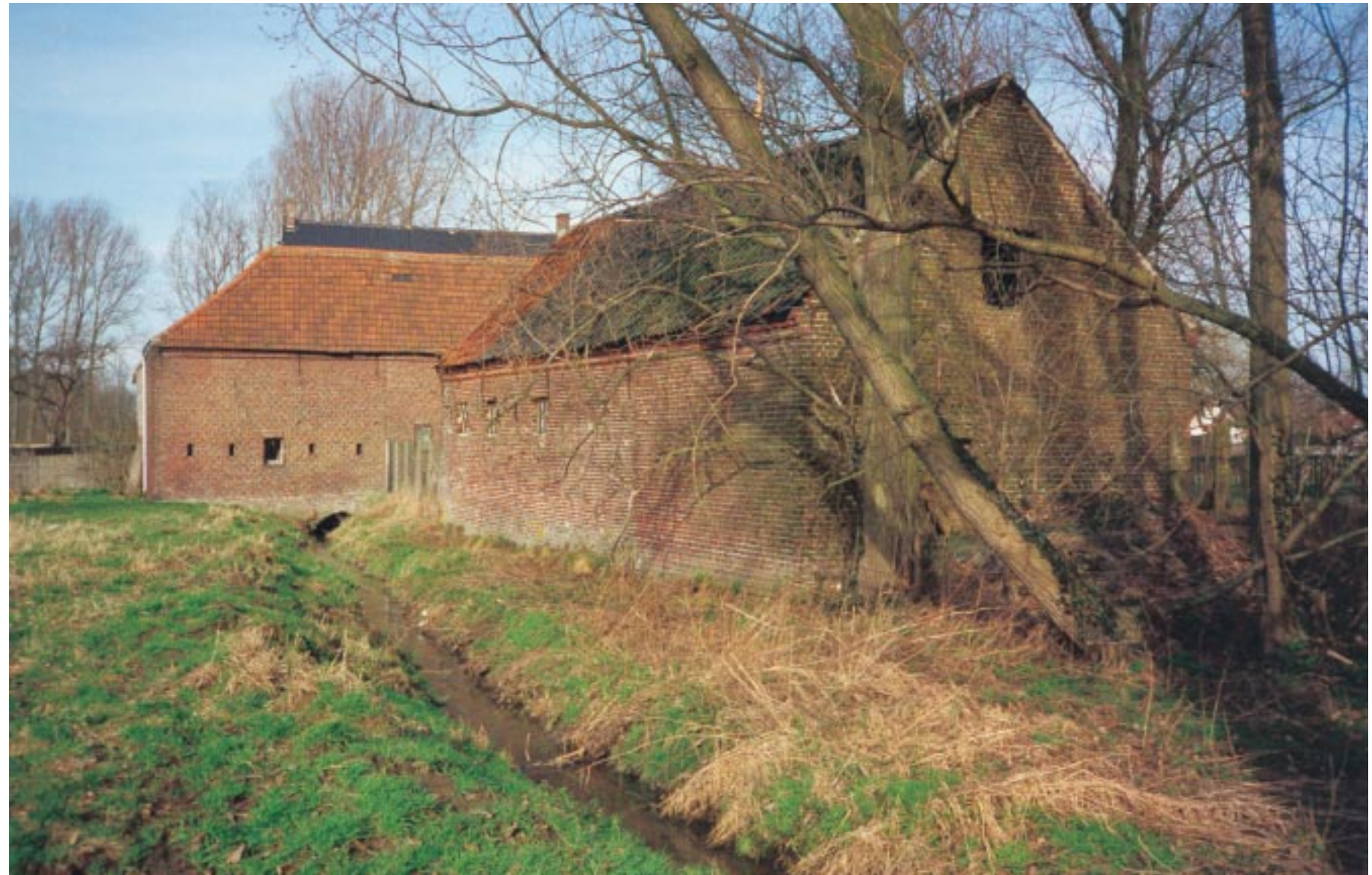
Een in onbruik geraakte by-pass aan de Ter Biestmolen te St.-Maria-Latem (Zwalm).
