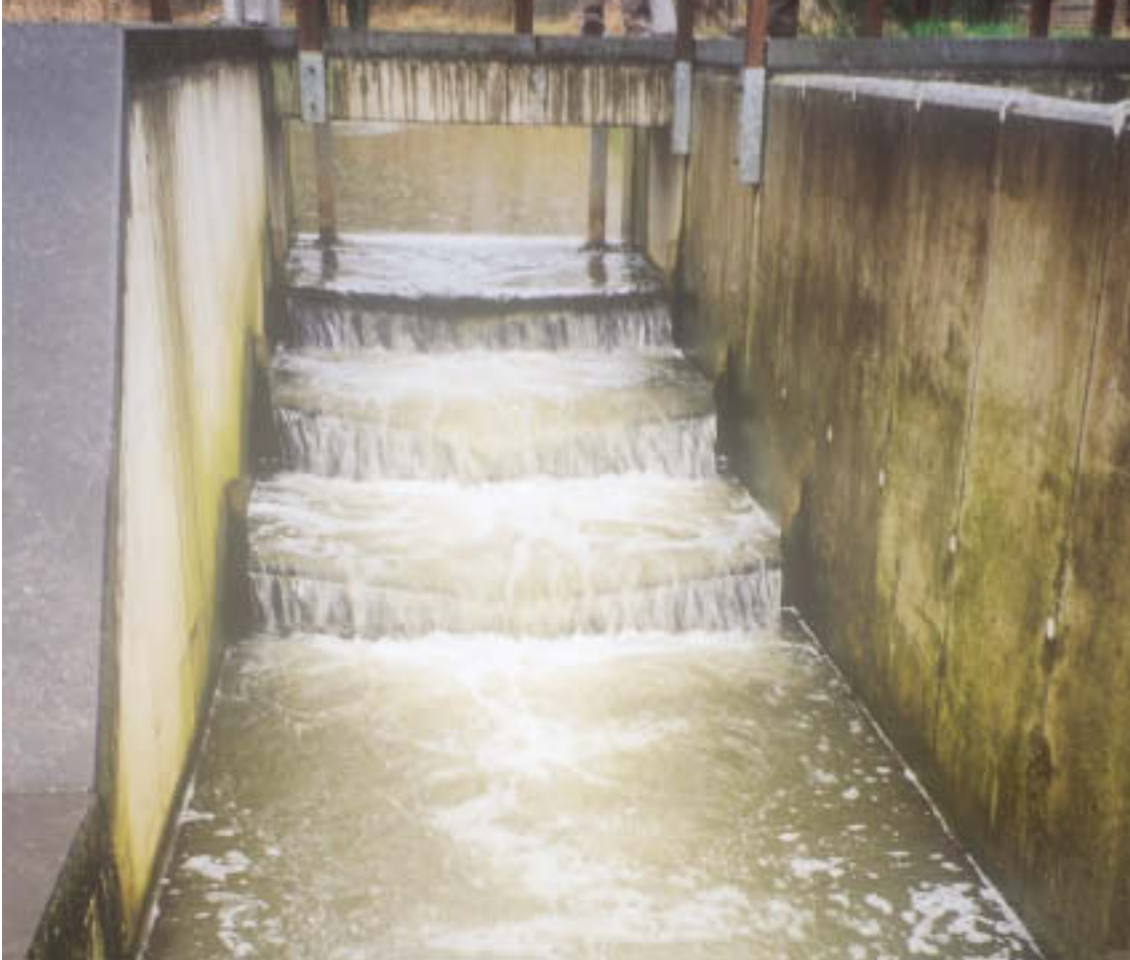
De vistrap aan de Arnoutsmolen te Kersbeek-Miskom. De bedoeling is om voldoende kleine watervalletjes te maken dat de vissen in staat zijn om er doorheen op te zwemmen naar het opwaarste pand van de Velpe.
