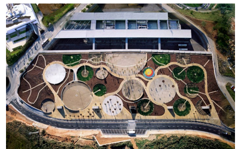
PARC DE TOIT SUR LE DÉPÔT DE BUS- HORTA BUS DEPOT, BARCELONA - DFT ARCHITECTS
