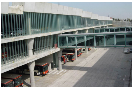
LE DÉPÔT EST CONSTITUÉ D'UNE ROBUSTE STRUCTURE EN BÉTON. - HORTA BUS DEPOT, BARCELONA - DFT ARCHITECTS
