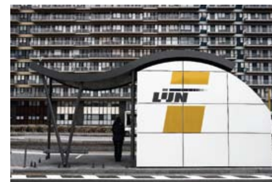
Aan de halte 'Renbaan', ter hoogte van het nieuwe bioscoopcomplex, opende De Lijn een nieuw type Lijnwinkel.
