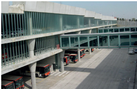
DE STELPLAATS IS OPGEBOUWD UIT EEN ROBUUSTE BETONSTRUUTUUR - HORTA BUS DEPOT, BARCELONA - DFT ARCHITECTS
