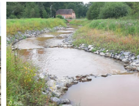
“Het juiste niveau van de trappen inschatten, is cruciaal. Als ze te laag zijn, stroomt de Nete als het ware leeg. Als ze te hoog zijn, kan er geen water in de passage.”
