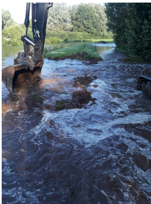
Figuur 35 – Dijkverlaging 2 (Kloosterbeemden) tijdens de aanleg met dijkverlaging 1 in werking op de achtergrond (19/07/2021)
