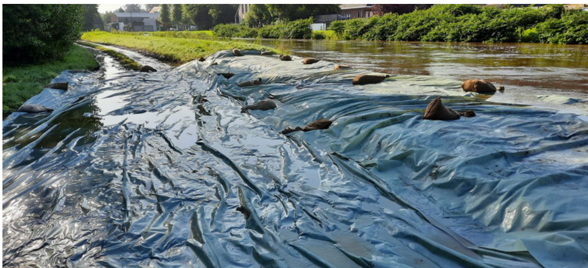
Figuur 32 – Dijkverlaging 1 (Kloosterbeemden) met begin van overtopping (18/07/2021)
