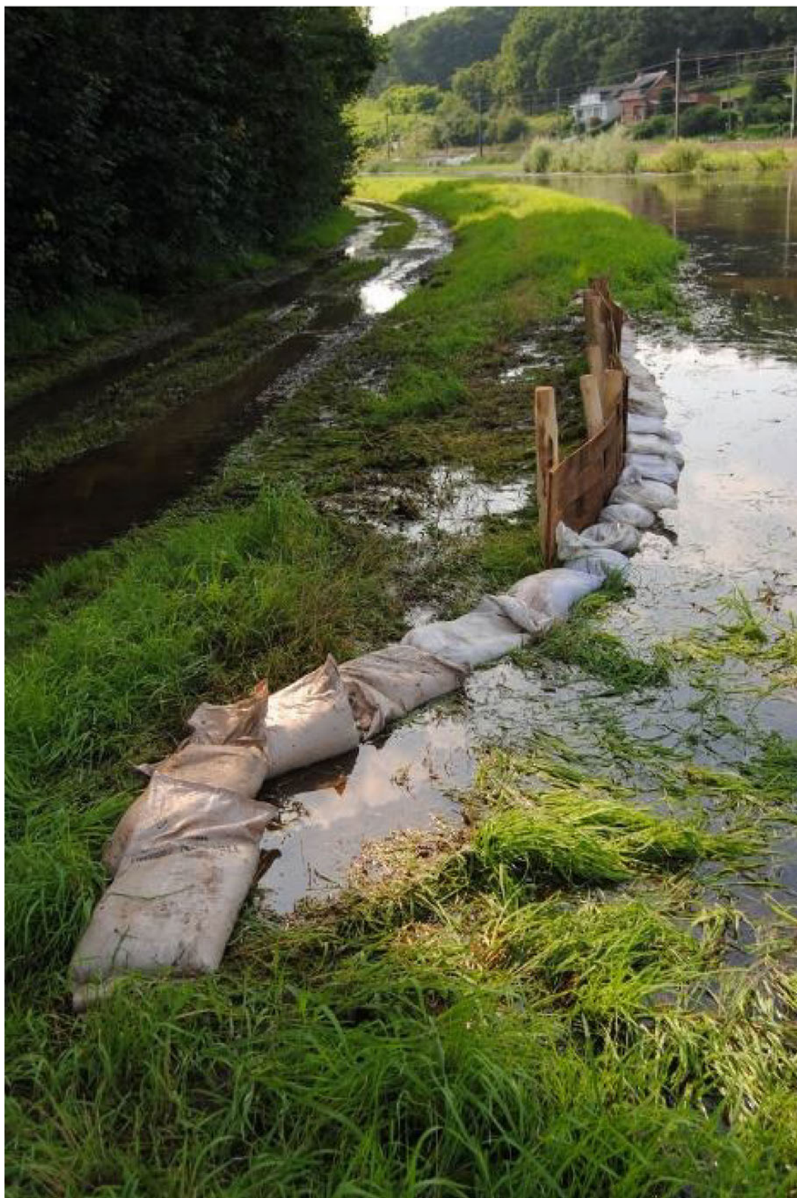
Figuur 54 – Afdamming van de overstroming op de linkeroever van de Demer nabij het Doodbroek (23/07/2012)
