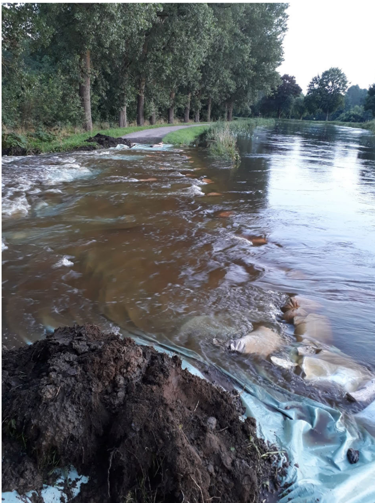
Figuur 38 – Dijkverlaging 3 (Molenstedebeek) in werking (19/07/2021)
