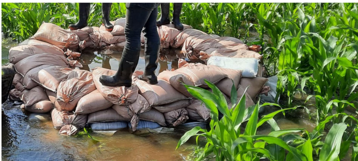
Figuur 33 – Opgekist beverhol op de linkeroever te Langdorp (18/07/2021)
