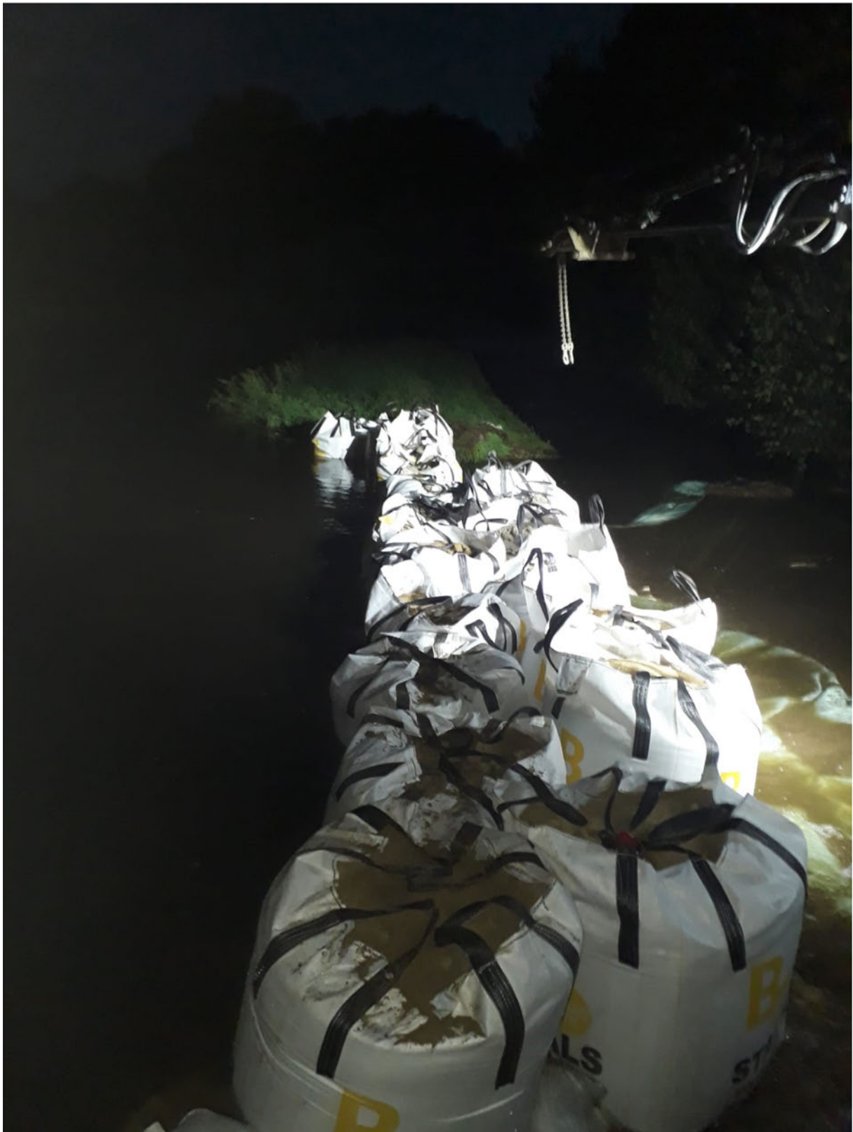
Figuur 49 – Dijkverlaging 2 (Kloosterbeemden) 85% afgesloten (20/07/21)
