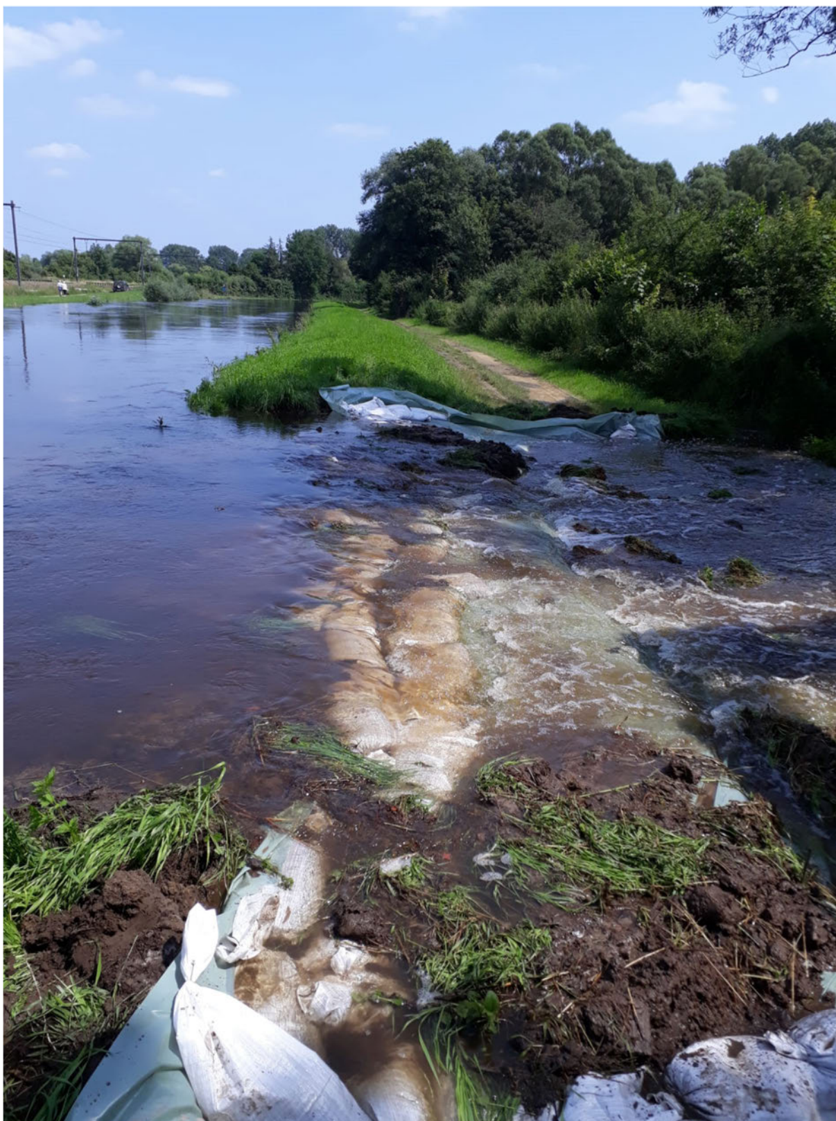
Figuur 47 – Dijkverlaging 4 (Doodbroek) in werking (20/07/2021)
