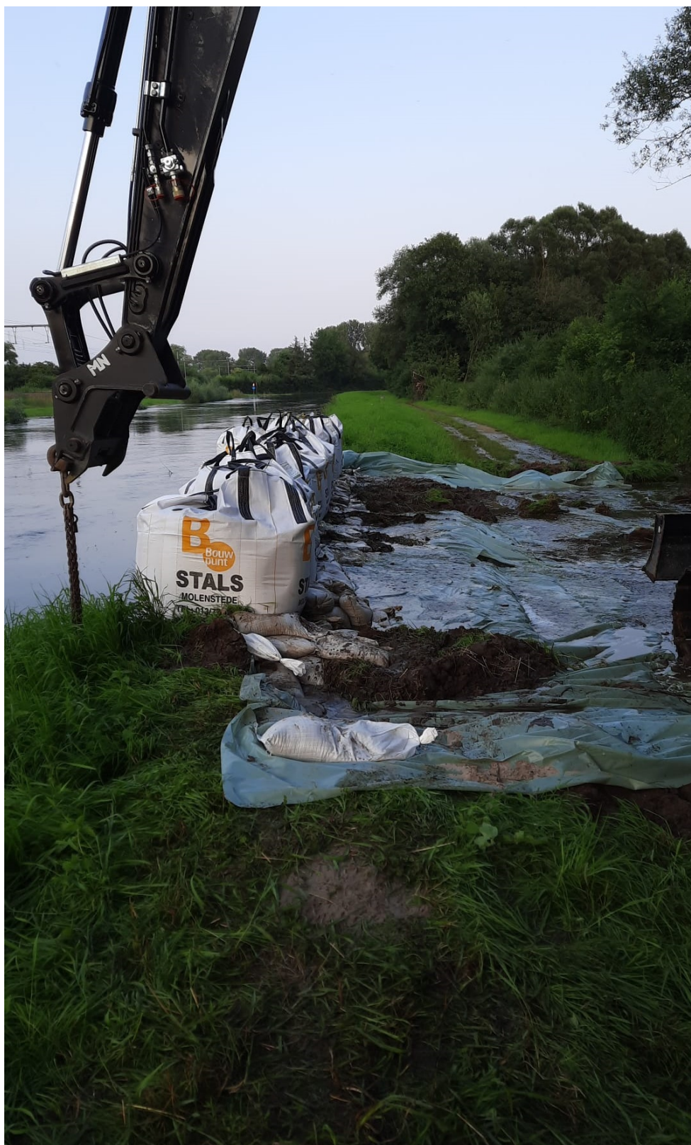
Figuur 50 – Dijkverlaging 4 (Doodbroek) afgesloten (21/07/2021)
