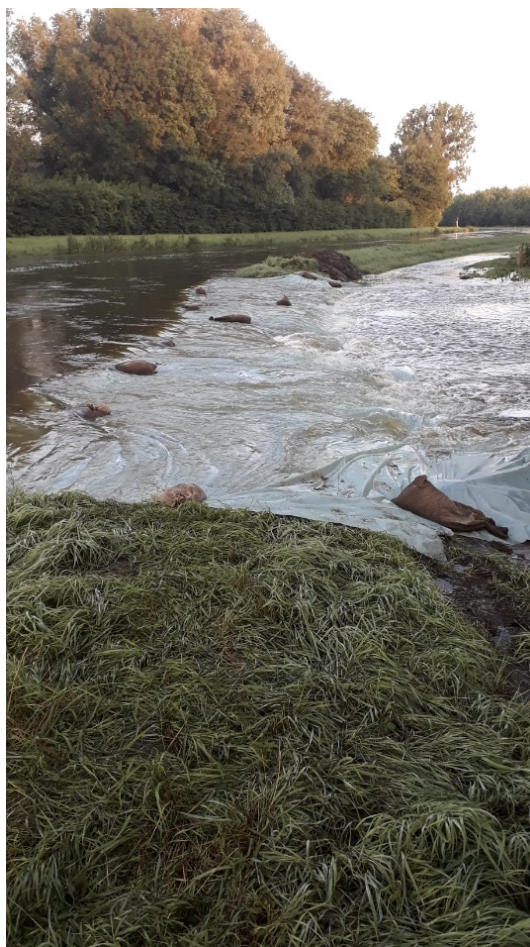
Figuur 34 – Dijkverlaging 1 (Kloosterbeemden) in werking (19/07/2021)
