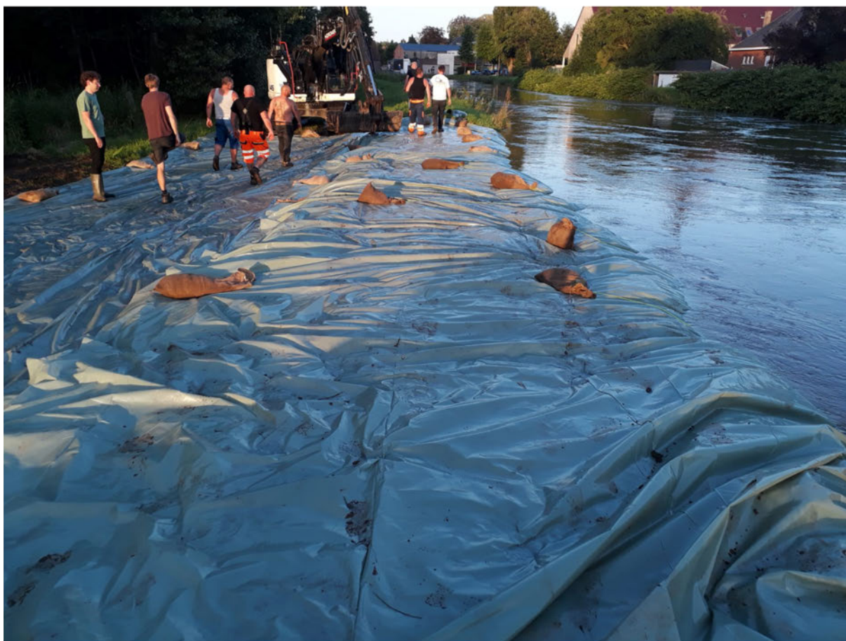
Figuur 31 – Dijkverlaging 1 (Kloosterbeemden) onmiddellijk na de aanleg, nog geen overtopping (17/07/2021)
