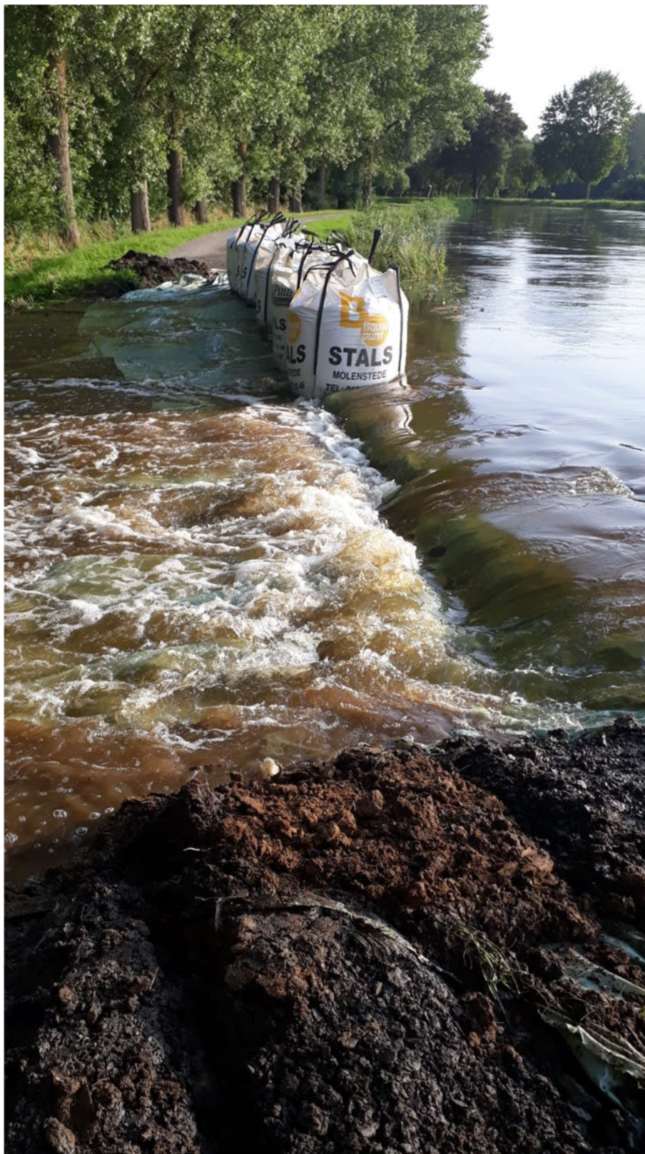
Figuur 48 – Dijkverlaging 3 (Molenstedeboek) half afgesloten (20/07/2021)
