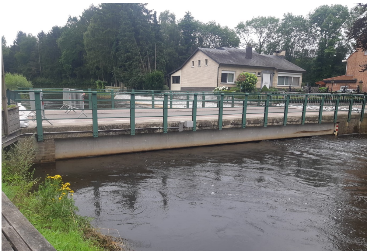
Figuur 41 – Aangesloten brug over de Demer te Testelt (24/07/2021)
