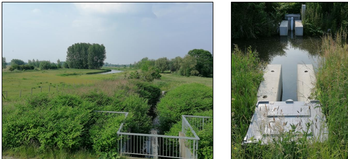
Figuur 14 – Links: zicht vanaf de Scheldedijk op de Driesesloot (rechts in beeld) en de Oude Schelde (achteraan). Rechts: de sleufval in de Driesesloot. (Foto's: B. D'hondt.)
