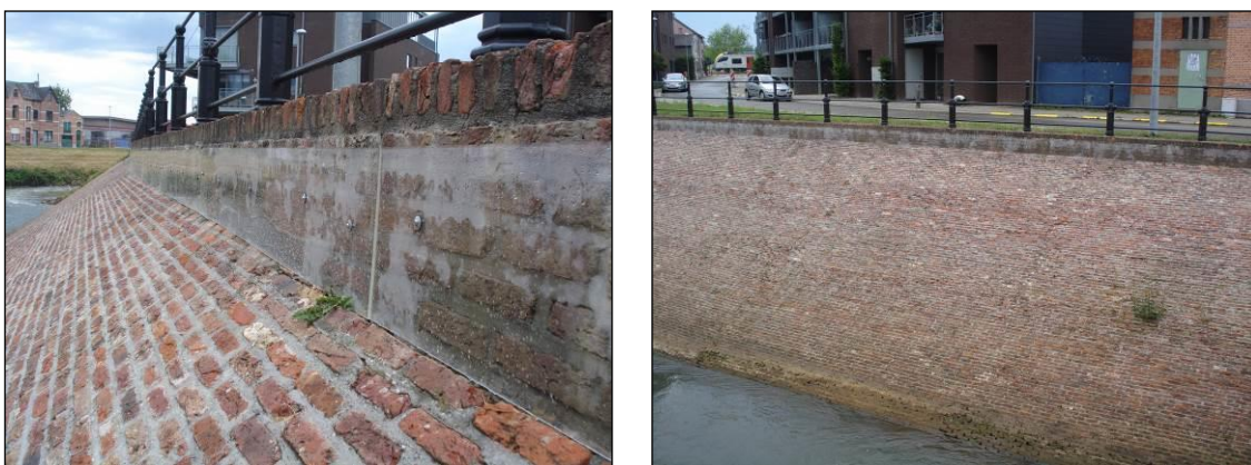
Figuur 8 – Een bewegingsbarrière voor wolhandkrabben langsheen de Demer te Aarschot (2017). Een lokale stroomversnelling t.h.v. een watermolen doet de krabben het water verlaten. Door een afscheiding in plexiglas wordt de overlast van zich over het land verspreidende krabben beperkt (Foto's: B. D'hondt.)
