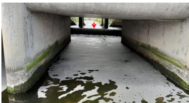
Figuur 28 Betonnen stuwte die de optrek van glasaal belemmert.
