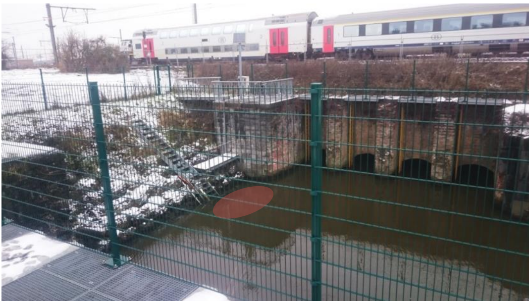
Figuur 8 Zicht op het begin van de ondergrondse koker vanop de duiker net stroomafwaarts het terugslagkleppencomplex van het Caemerlinckxgeleed. De artificiële substraten werden tussen de trap en de bakstenen oever geplaatst (rode cirkel).
