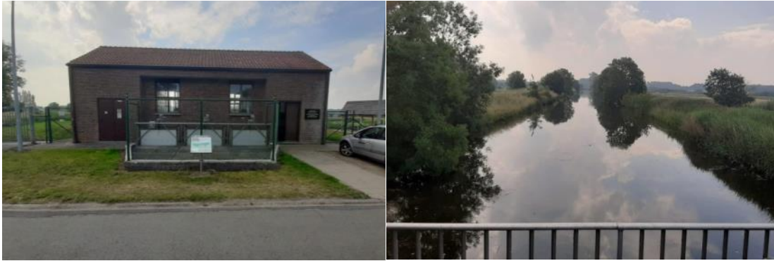
Figuur 16 Pompemaal Kwetshage-Paddegat (links) ter hoogte van de monding van de Jabbeekse beek (rechts) in het Kanaal Gent-Oostende.
