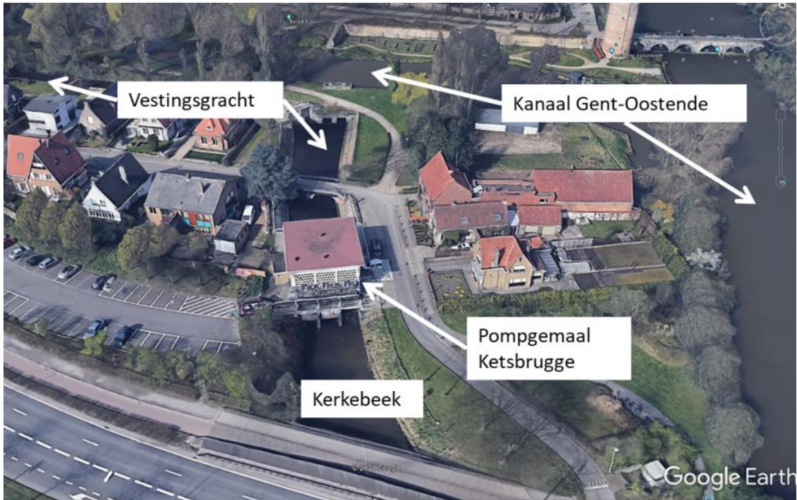
Figuur 40 Afbeelding van het pompgemaal Ketsbrugge (bron: Google Earth).
