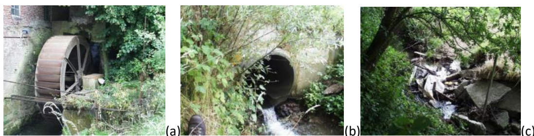
Figuur 104 Onopgeloste knelpunten op de Traveinsbeek. (a) Molen Van Den Borre, stroomafwaarts van de monding van de Pauwelsbeek in de Traveinsbeek. (b) duiker met verval van 15 cm, 200 m stroomafwaarts van De Vlamme. (c) Onnatuurlijke barrière van afval stroomopwaarts van de monding van de Karnemelkbeek in de Traveinsbeek.
