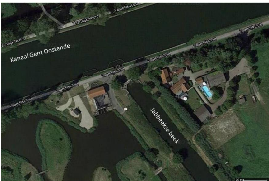
Figuur 17 Luchtfoto van pompemaal Kwetshage-Paddegat ter hoogte van de monding van de Jabbeekse beek in het Kanaal Gent-Oostende.
