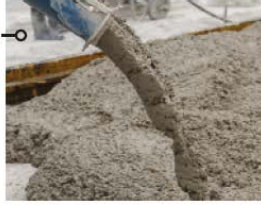
ter plaatse gegoten beton
