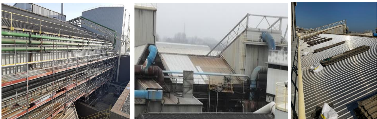
Figuur 32: Voorbeelden van dichtmaken wanden en daken. Foto links: herstellen van westwand gieterij - Foto Midden: Herstelling dak oost gieterij - Foto Rechts: Herstellen dak west gieterij.
