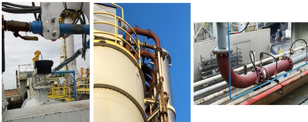
Figuur 34: Aanpassingen aan silo's met milieu gevaarlijk: Foto Links: Tribo om de geringste stofdoorslag van de silo filter te detecteren - Foto midden en Rechts - Stofzendingleidingen zijn dubbelwandig uitgerust en gebruik van keramische bochten.
