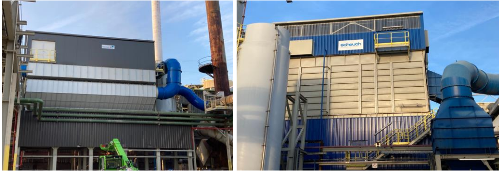
Figuur 35: Foto Links: Doekenfilter 10T1 oven (december 2017) - Foto Rechts: Doekenfilter anode oven (juli 2020).
