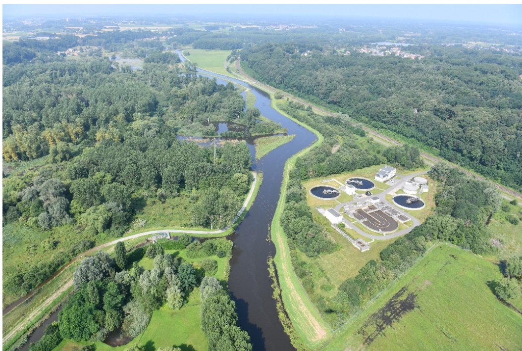
Figuur 3 – Voorbeeld van beboste percelen (links van de Demer) waarvan het niet duidelijk is of ze overstroomd zijn
