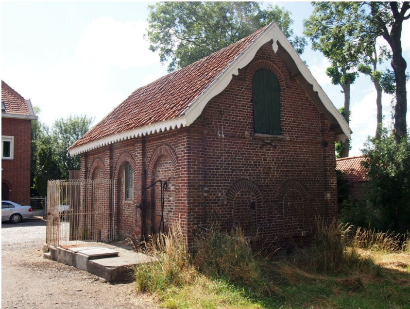
Foto 3: Wagenkot met zijgevels die geritmeerd worden door lisenen en rondboognissen (foto archief VLM).
