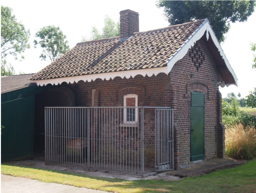
Foto 2: Voormalig bakhuisje met puntgevel met in de top geometrisch metselpatroon in ruitvorm (foto archief VLM).
