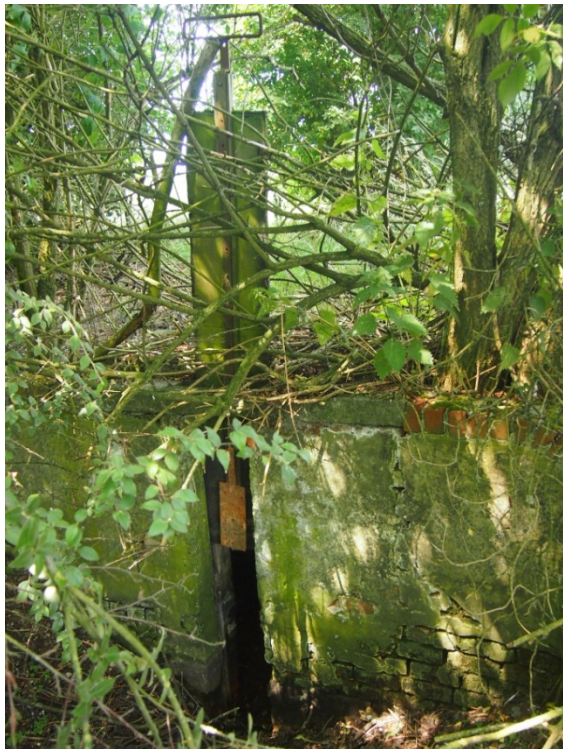
Foto 5: Stuw aan de voormalige Leiearm t.h.v. het 'Eilandje'. Hiermee werd het waterpeil geregeld in de periode dat de vlaskapellekes in de Leievallei stonden (fotoarchief VLM)
