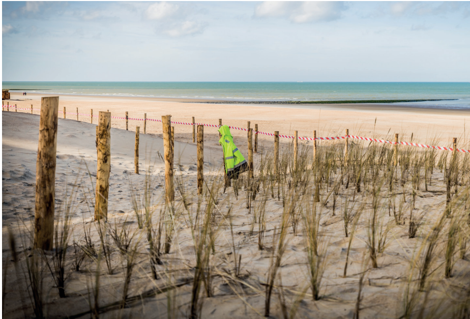
Aanleg duin voor dijk in Westende (Middelkerke). Bron: agentschap MDK
