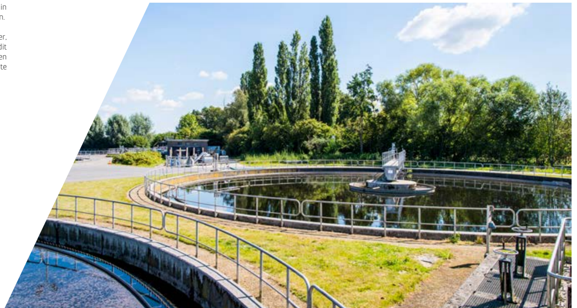
Rioolwaterzuiveringsinstallatie: een bezinkbassin van één van de meer dan 300 RWZIs in het beheer van Aquafin. / Aquafin
