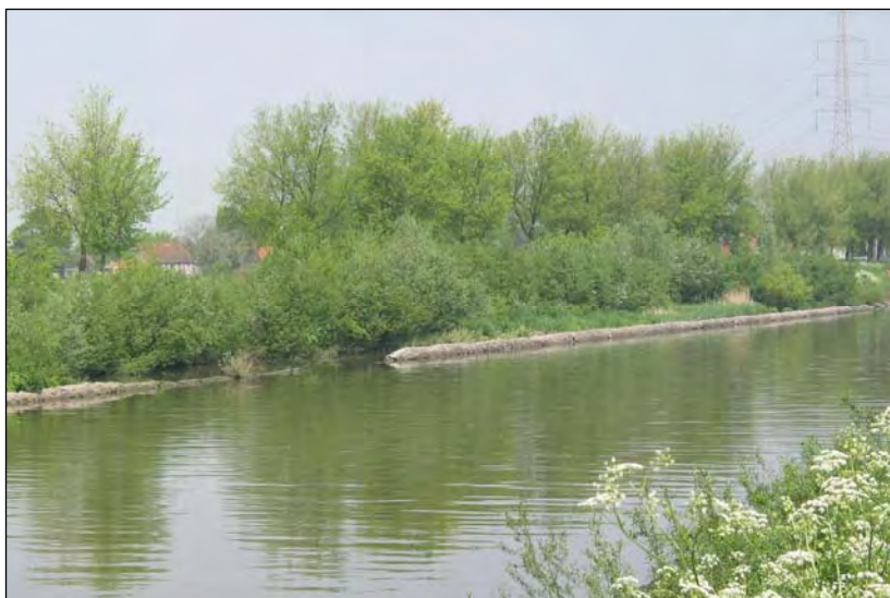
Foto 13: Te Grammene werd in het kader van een oeverzwaluwproject door Aminoal cel NTMB een vooroever aangelegd voor een afgekalfde wand, om zo de overmatige afkalvingen tegen te gaan, en de oeverzwaluwkolonies een duurzame nestlocatie te bieden. Door het gebrek aan dynamiek verzandde en verzakte de oever echter, waarop ze verboste met wilgenstruweel. Hierdoor werd de locatie ongeschikt als broedplaats voor oeverzwaluwen. Er dient een oplossing gezocht die een beperkte dynamiek en afkalving toelaat, of er dient een beheer uitgewerkt die de afkalving onderhoudt.
