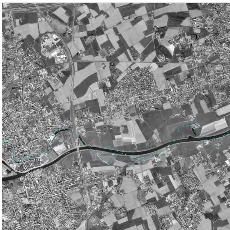
Foto158: Menen en Wevelgem Pesserie : orthofoto 2000. De meersen te Menen en ten zuiden van de Leie zijn volledig opgehoogd; de Leie is rechtgetrokken en ingedijkt
