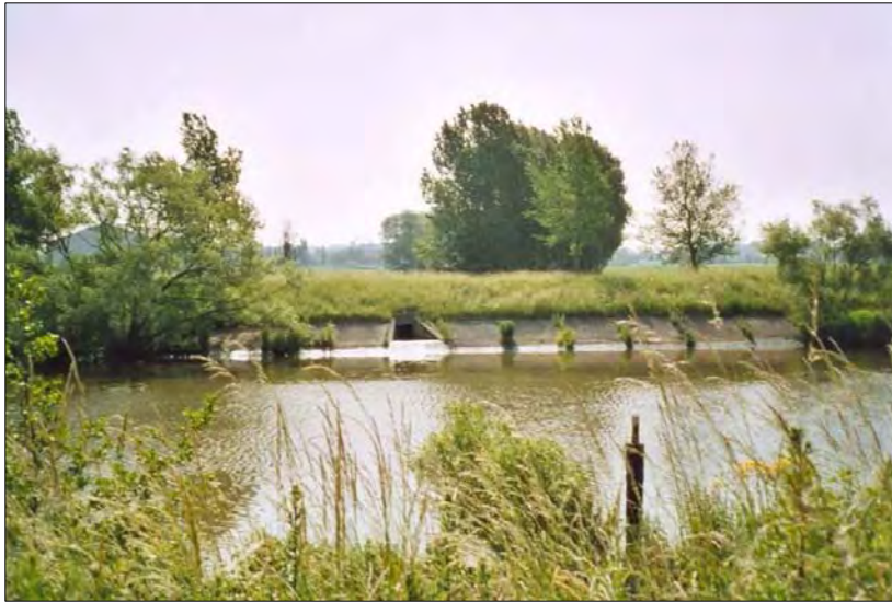
Foto 1: Stroomafwaarts Sint-Baafs-Vijve zijn de Leieoevers verdedigd met betonnen damplanken. Deze laten geen ruimte voor oever-ontwikkeling (enkel wat gras en wilgenopslag tussen de platen). De meander Ponthoek mondt ingekokerd uit boven het Leiepeil. Links hiervan, ter hoogte van de vroegere meanderafsnijding, bestaat de oeververdediging uit stortstenen. Hierop heeft zich wilgenstruweel ontwikkeld.
