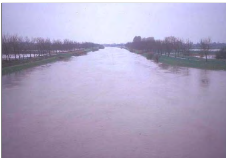
Foto 33: De gekanaliseerde Leie tijdens de hoge was van 2002, t.h.v. Machelen-Gottem. Er stroomt een erg groot debiet door de Leie, en het waterpeil is hoog. De grondbermen hebben hier echter geen waterkerende functie; zelfs zonder bermen zouden de meersen hier niet overstromen. Plaatselijk staan de omliggende meersen onder water, dit is echter voornamelijk neerslagwater.
