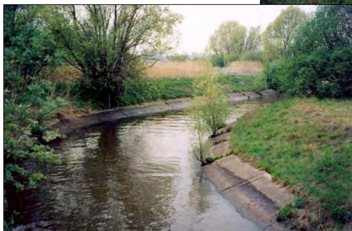
Foto 130: De oevers bij de monding in de Leie zijn verdedigd met betonnen damplanken. Verwijderen van de oeerverdediging, met het graven van een zachthellende gradiëntrijke oever in aansluiting met het aanpalende opgehoogde terrein, is hier aangewezen.
