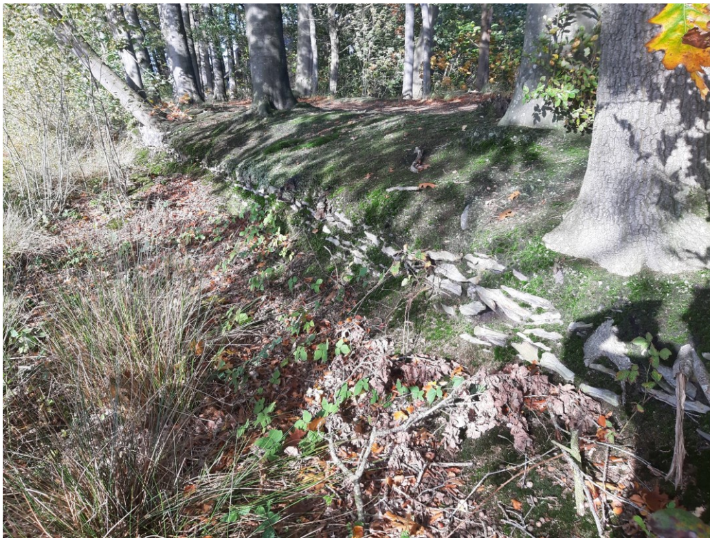
Foto 3: Ringdijk met oeverversteving in lokale veldsteen (foto @ vlm, 2019)
