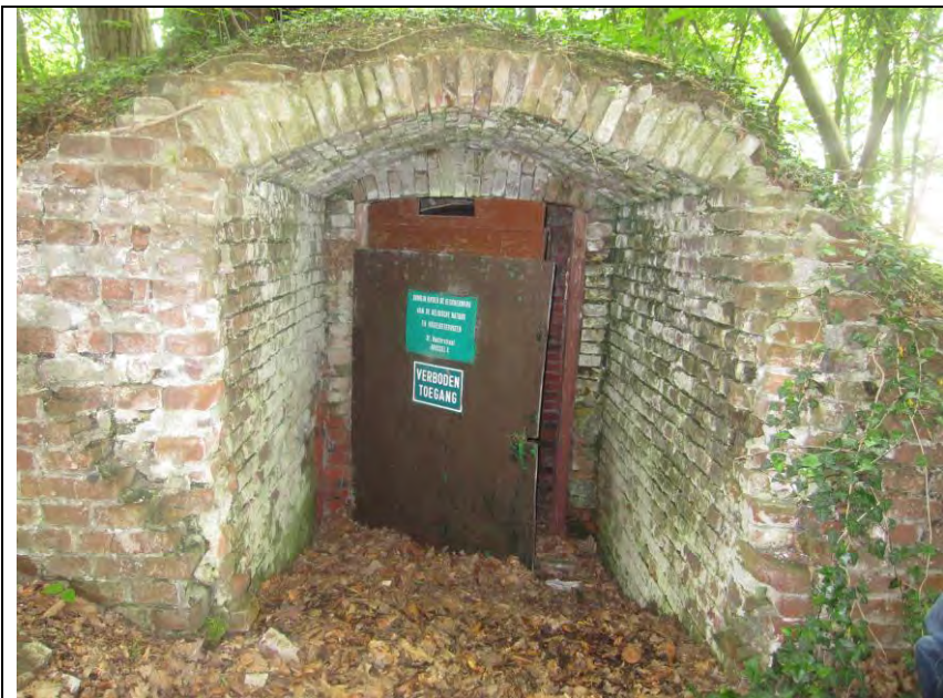
Foto 22: Te restaureren toegang tot ijskelder kasteelpark Wildenburg
