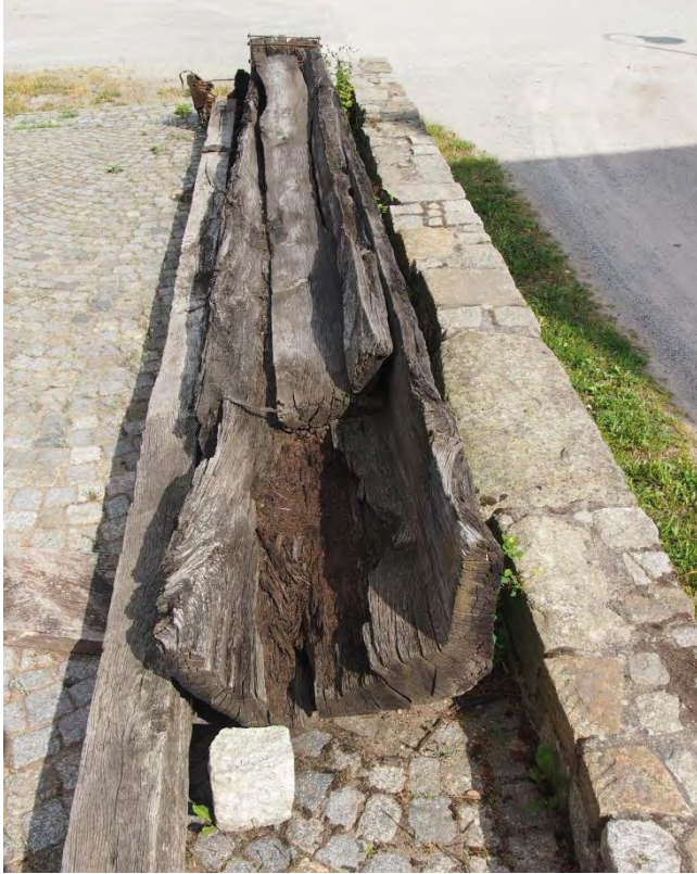
Foto 9 en 10: Houten goot met tap die instond voor de afvoer van het vijverwater, Informationszentrum Sächsische Teichwirtschaft (foto Frank Debeil, 2015).
