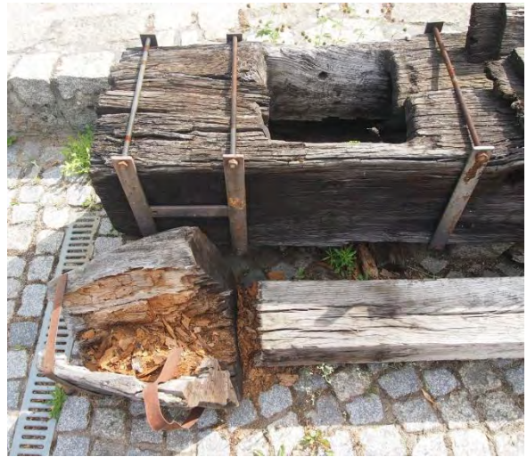
Foto 9 en 10: Houten goot met tap die instond voor de afvoer van het vijverwater, Informationszentrum Sächsische Teichwirtschaft (foto Frank Debeil, 2015).
