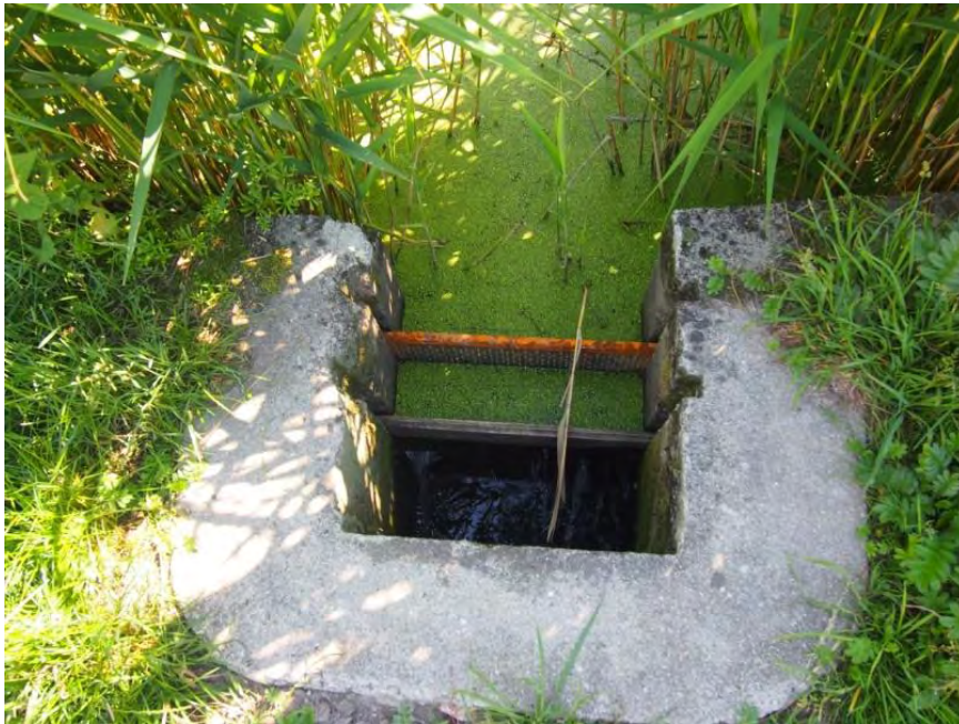
Foto 6: Detail waterafvoerconstructie van een van de vijvers in het vijvergebied van Guttau (foto Frank Debeil, 2015).
