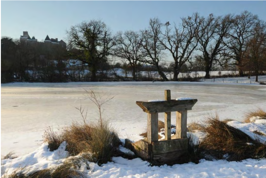
Foto 4: Uitlaatconstructie van een visvijver in de Brenne met op de achtergrond het kasteel van Le Bouchet (foto Guido Wauters).
