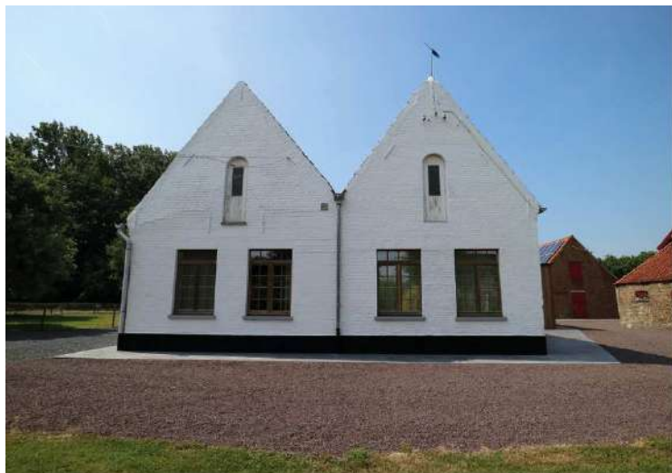
Woonhuis met geïntegreerde stallingen (1)
