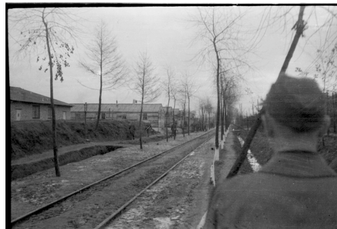
Figuur 28: Zicht op spoorlijn met jonge boompjes (bron: archiefdienst Zedelgem)
