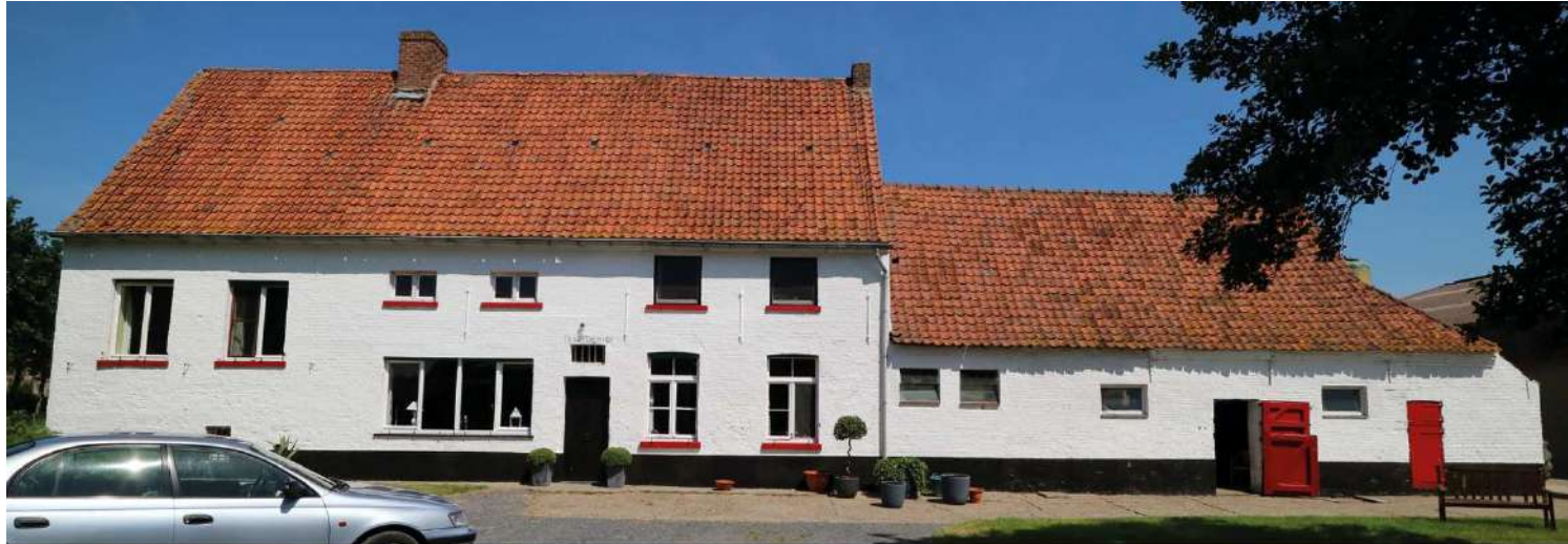
Woonhuis (1) met geïntegreerde stallen
