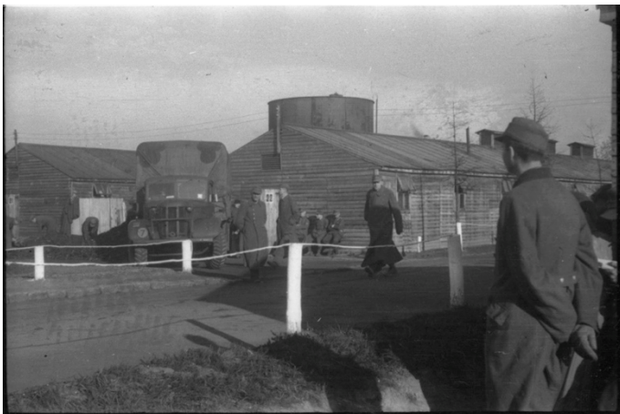
Figuur 18: Zicht op barakken van krijgsgevangenen (bron: archiefdienst Zedelgem)
