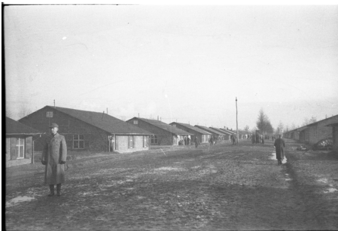
Figuur 25: Zicht op barakken van krijgsgevangenen (bron: archiefdienst Zedelgem)
