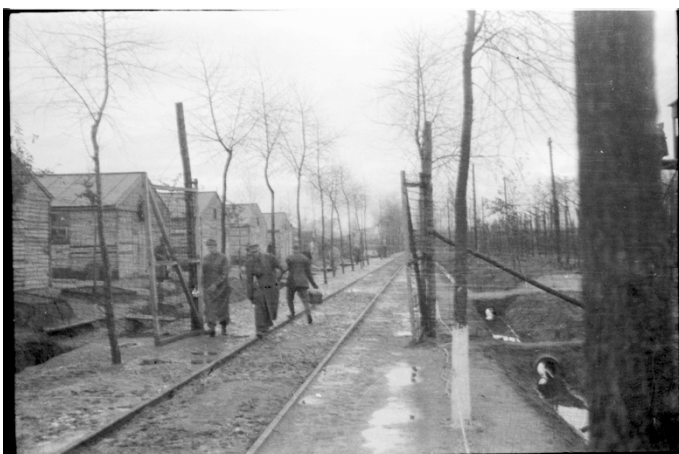
Figuur 20: Zicht op spoorlijn met jonge boompjes (bron: archiefdienst Zedelgem)
