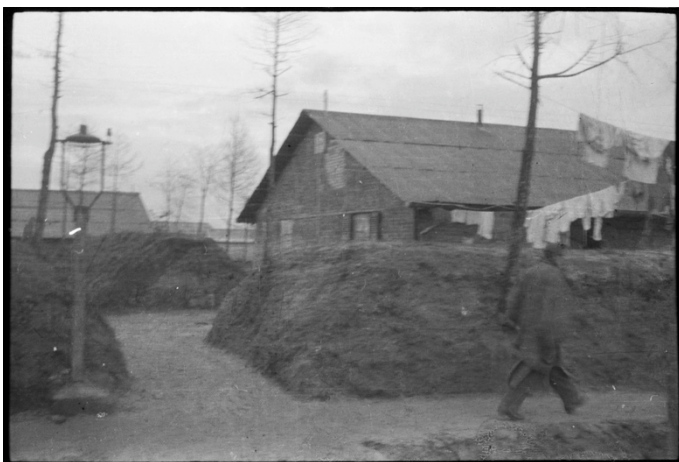
Figuur 23: Zicht op barakken van krijgsgevangenen met merlons (bron: archiefdienst Zedelgem)
