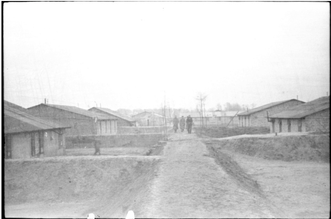
Figuur 24: Zicht op barakken van krijgsgevangenen met merlons (bron: archiefdienst Zedelgem)
