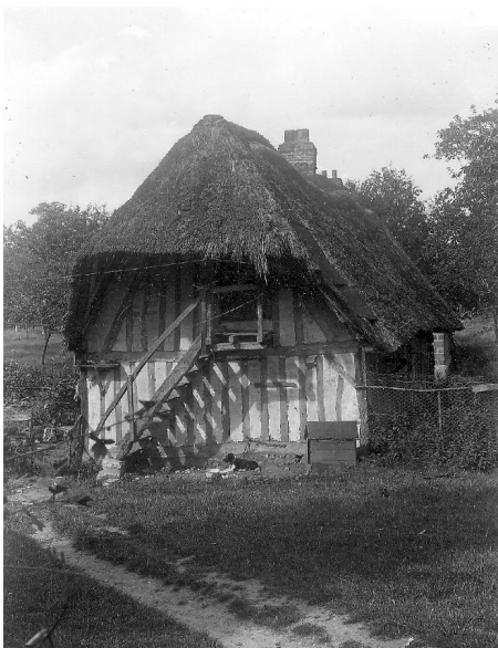
Figuur 71: Kleine middeleeuwse schuur in vakwerk- en leembouw, Groenstraat te Zuienkerke
