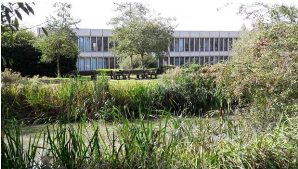
Figuur 15: Achterkant gebouw Oostende
