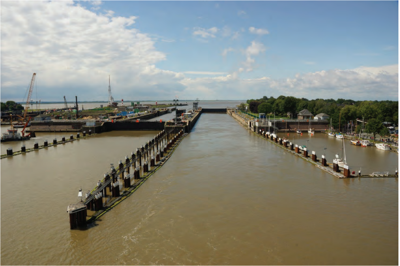
Figuur 9 – Sluisgeleiding op het Kielkanaal (Duitsland) te sluis Brunsbüttel als inspiratie voor ontwerp in simulaties
