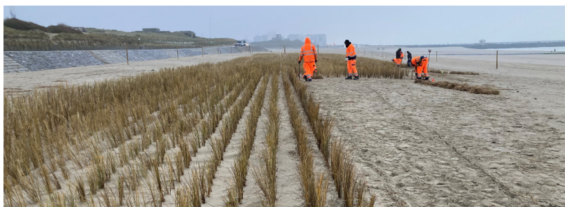
Figuur 2 – Aanleg duin voor dijk pilot thv Spinoladijk (Oostende). Foto 27/1/2021
