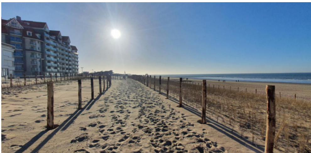
Figuur 7 – Grasdijk te Middelkerke in aanbouw (middelkerke.be). NB de paden zijn daarna nog verhard (schelpenzand)
