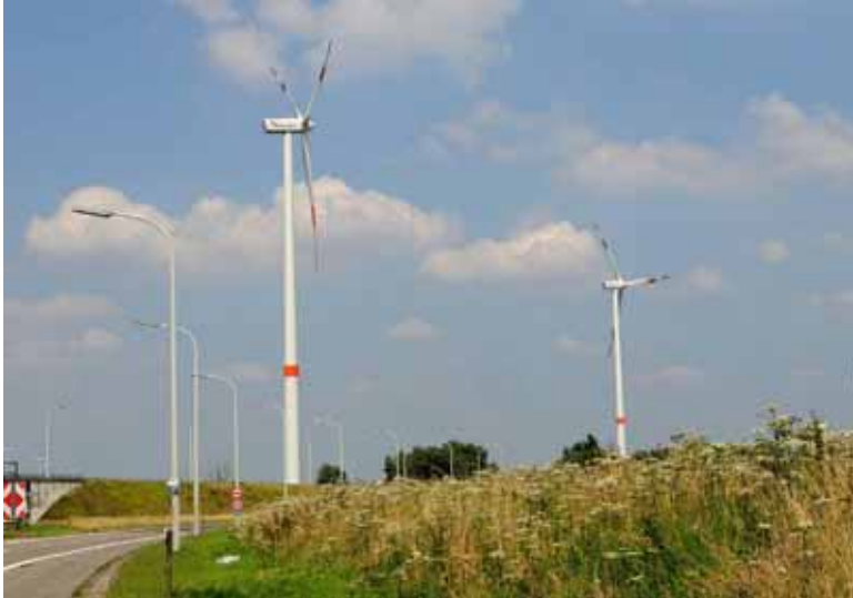
Figuur 128 Windturbines langs A12/Rupeltunnel in Puurs.
