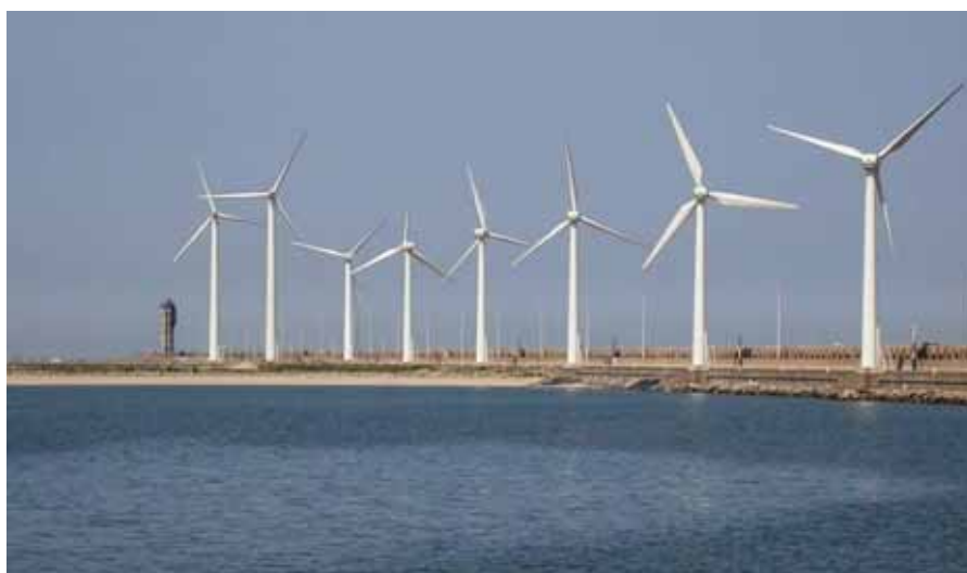
Figuur 8 Noordelijk deel van het windpark langs de oostelijke strekdam.
