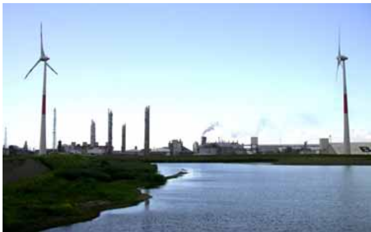
Figuur 124 Windturbines nabij de Zandvlietsluis in het Antwerps havengebied.
