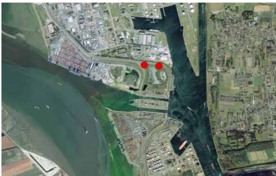
Figuur 125 Windturbines nabij de Zandvlietsluis in het Antwerps havengebied.
