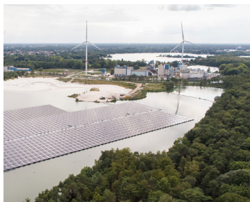
De Schans zandaufgraving + (zonne)energieproductie
