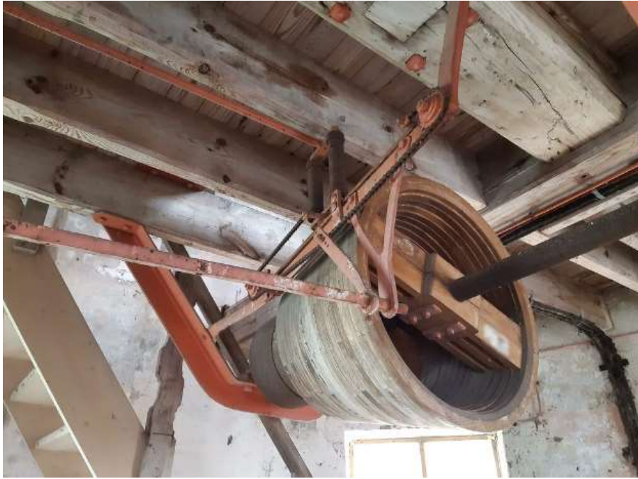
Windmolen Ronsemolen (Gistel), ijzeren overbrengingsas met een ijzeren en een houten riemschijf voorzien van een drijfriem
