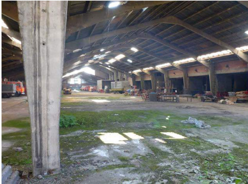
Foto 8 Zicht binnen in de voormalige steenfabriek (1)
