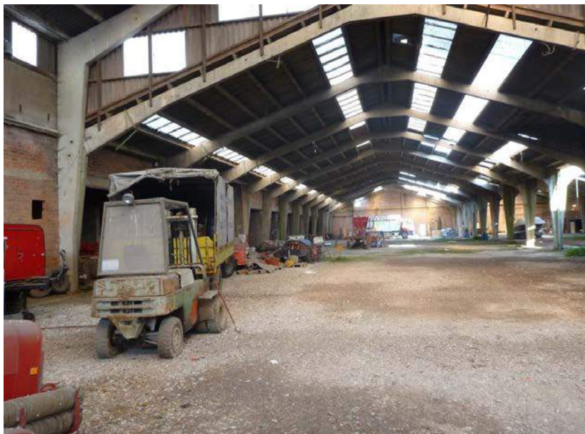
Foto 9 Zicht binnen in de voormalige steenfabriek (2)
