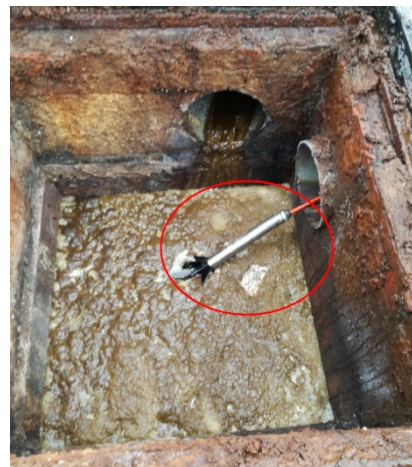
Gebruik van een rioolcamera om het buizenstelsel in kaart te brengen.
