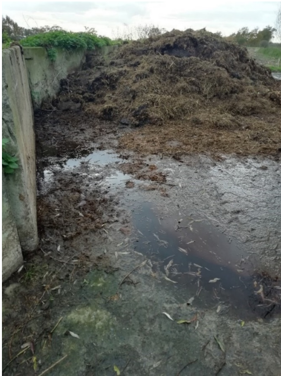
Opslag van vaste mest voldoet niet aan de constructievoorschriften VLAREM en mestsappen vloeien naar de gracht
