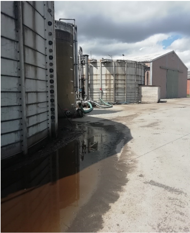
Mestsappen bij een opslagbekken voor ruwe mest op een biologische mestverwerkingsinstallatie
