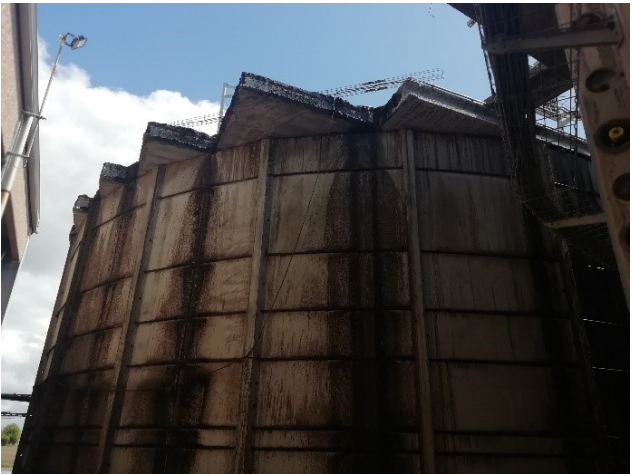
Overgelopen opslag van ruwe mest op een biologische mestverwerkingsinstallatie (calamiteit volgens de uitbater)
