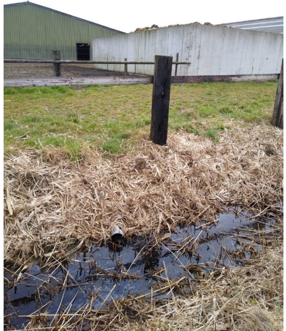
Lozing in de gracht van mestsappen afkomstig van een opslag van vaste mest
