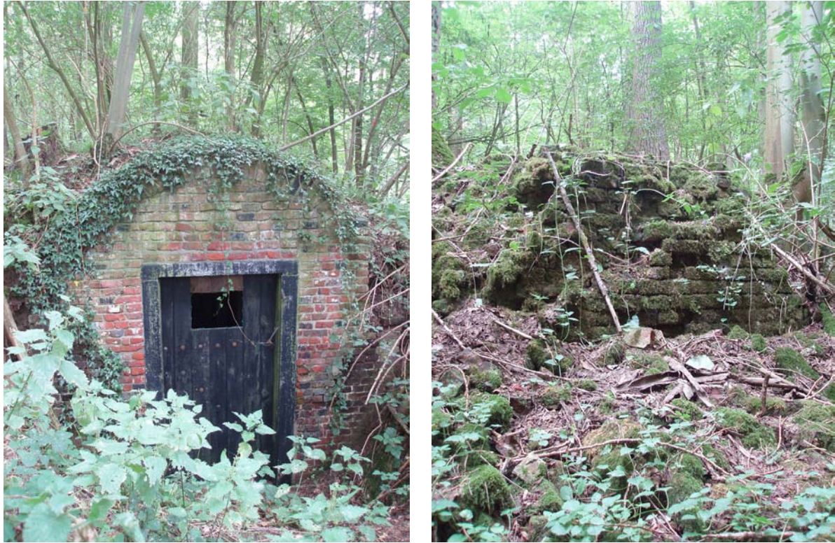
Figuur 6.3: De ijskelder en de restanten van het brugje bij de vijver, in het noorden van bosreservaat Ter Rijst (foto's: Peter Van de Kerckhove).
