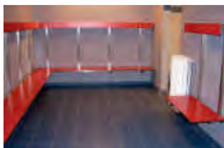
Groepskleedruimte met een vrije transferruimte langs de zitbank zodat een rolstoelgebruiker makkelijk kan plaatsnemen.
