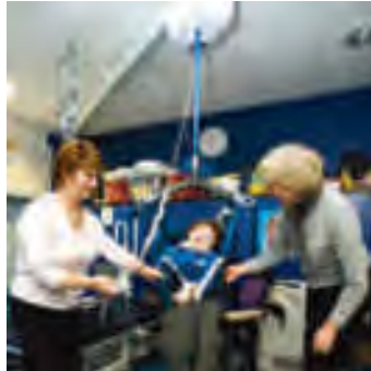
Een plafondlift met een enkelvoudig systeem.
