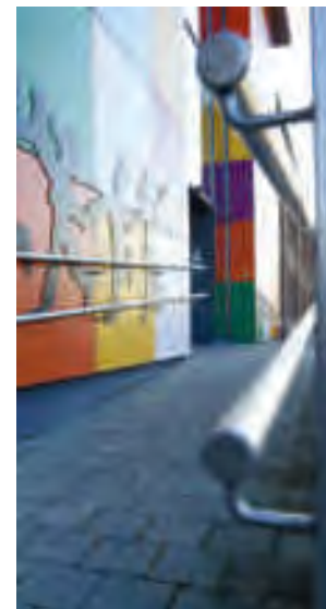
Niveauperoverbrugging door een combinatie van helling en trap. Beiden hebben een goede leuning.
