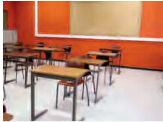
Technische uitrusting van een klas: een kabelgoot rondom de klas zorgt voor verschillende aansluitpunten.
