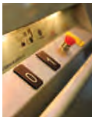
Dodemansbediening van de verticale plateaulift.
