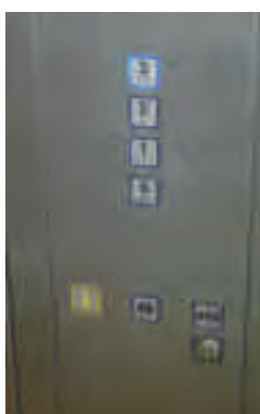
Oplichtende bedieningsknoppen met tactiele aanduiding en braille.
