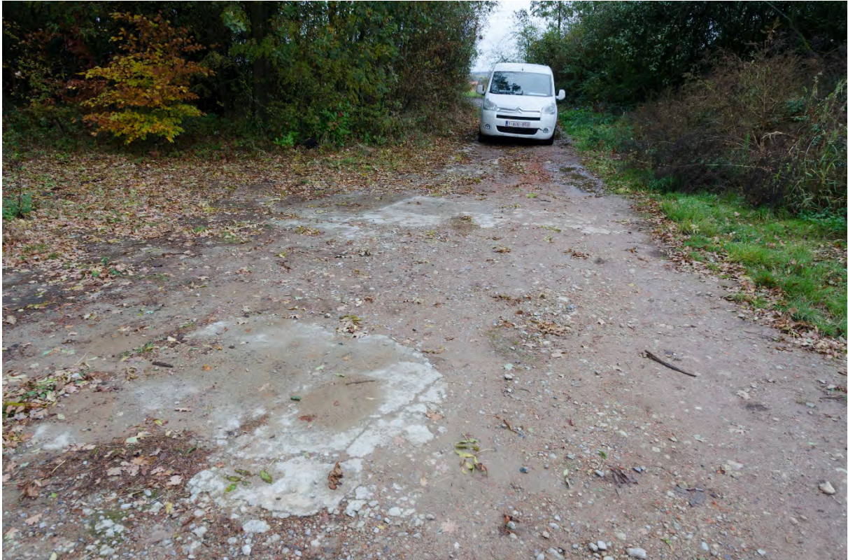
Foto 57 – Relict 1 Betonverharding uit WO2
