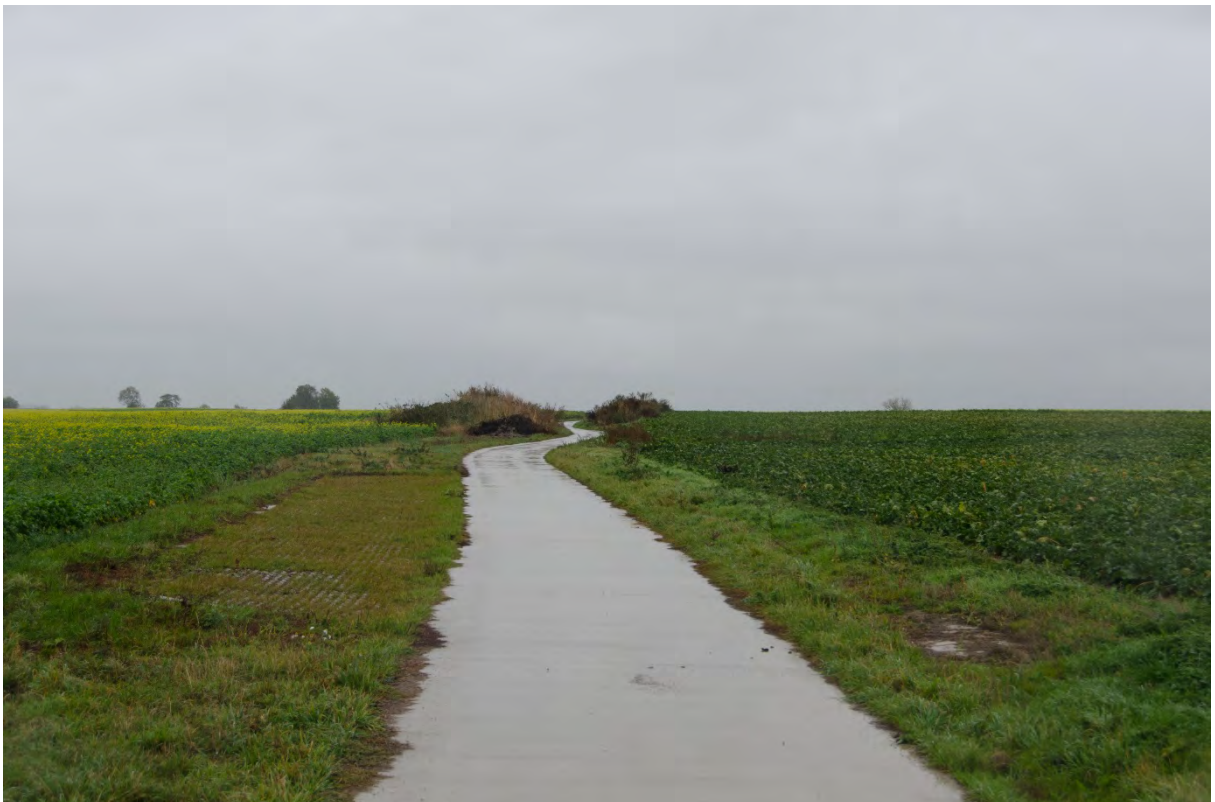
Foto 76 – relict 4, nieuwe betonverharding thv de Weg van Croix-Gettoux, met op voor- en achtergrond de gespaarde betonrelicten thv de wegbermen
