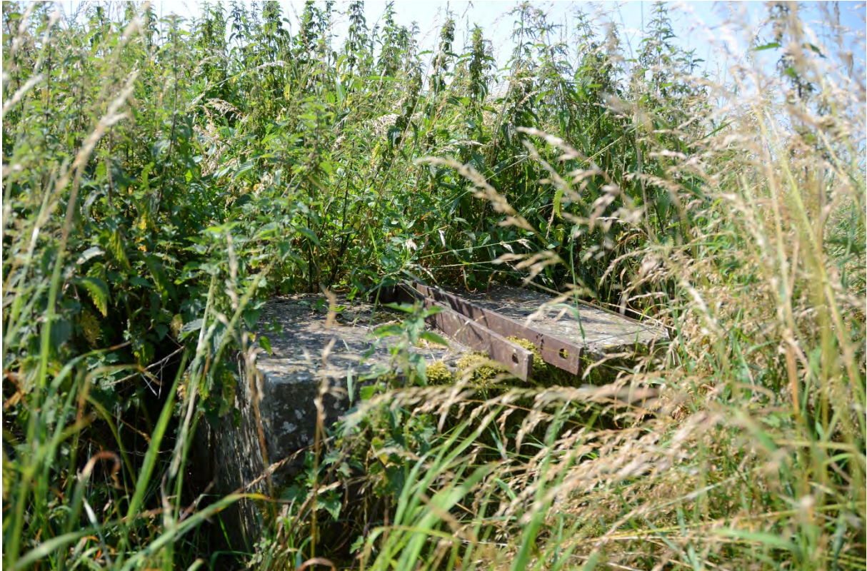
Foto 68 – relict 3, betonanker op oostelijke aviolle
