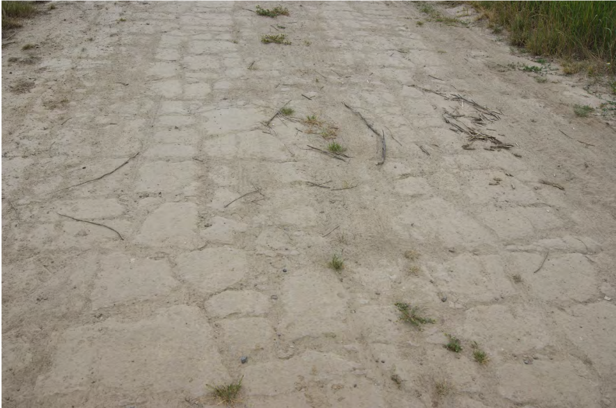
Foto 75 – relict 4, detail foto van de betonverharding
