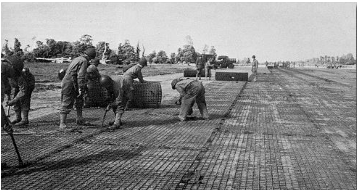
Foto 23 – aanleg van de Amerikaanse startbanen van stalen matten
