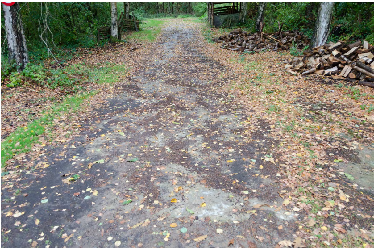
Foto 58 – Relict 1 Betonverharding uit WO2 (Wallonië)
