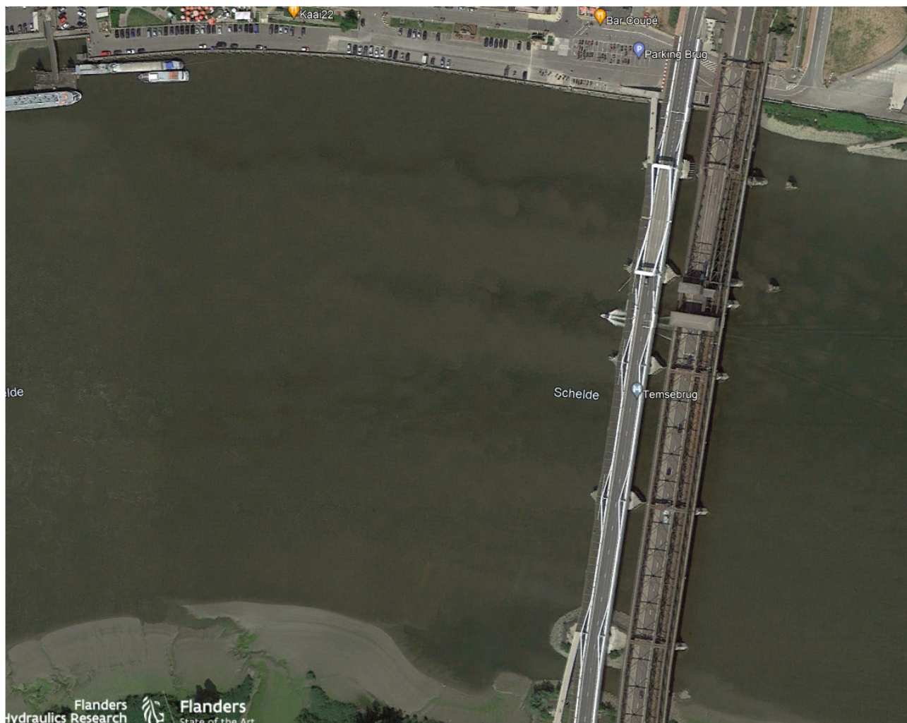
Figuur 60 – Zog pijlers brug Temse
