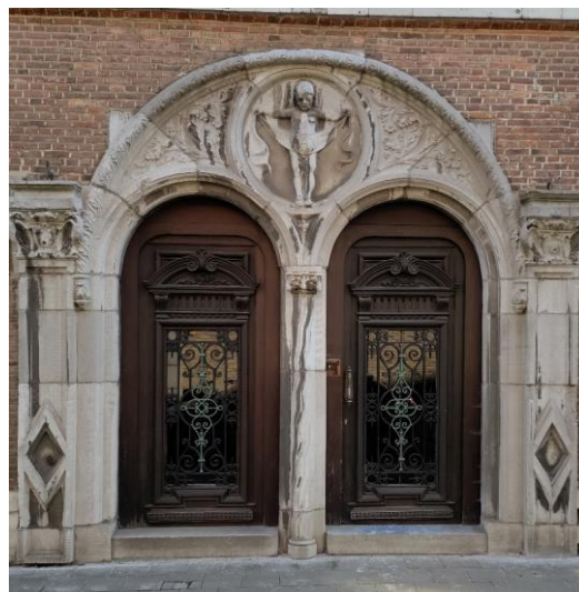
Figuur 96. Dubbele voordeur aan straatzijde die niet gebruikt wordt. (Foto: WTCB)
