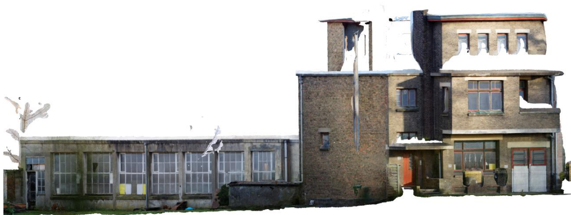
Figuur 140. 3D fotogrammetrische reconstructie op basis van enkele foto's vóór de renovatiewerken (2017). (©WTCB)
