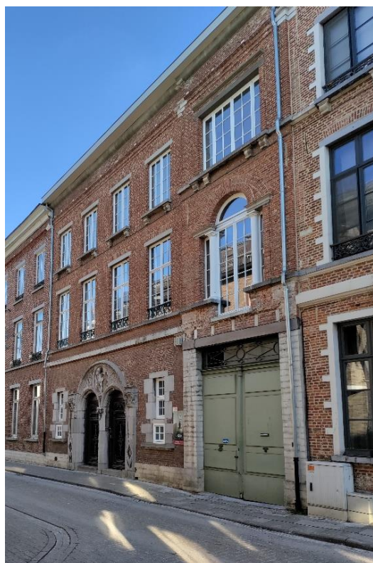
Figuur 88. De voorgevel na renovatie (2021). (Foto: WTCB)
