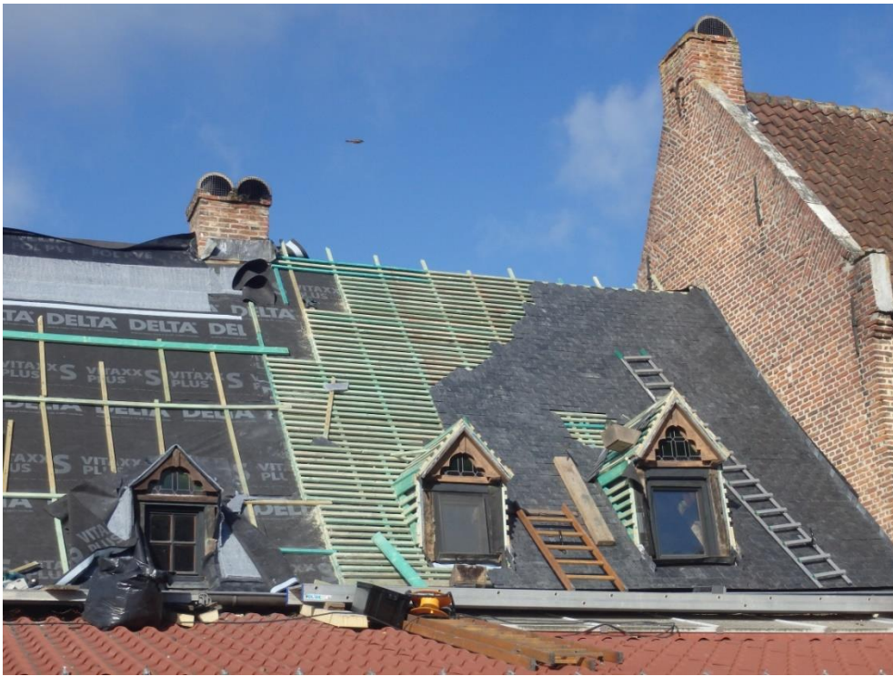
Figuur 58. Links de onderdakfolie, rechts de leibedekking op panlatten. (foto: Dakwerken Gebroeders Van Loy)
