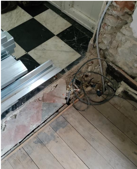
Figuur 9. Zone met drie types vloer tussen gang en leefruimte waar een muur is afgebroken. De keramische tegels zijn wellicht het oudst; de stenen vloer in dambordpatroon en de houten plankenvloer vermoedelijk eind 19 de -eeuws of vroeg 20 ste -eeuws.(Foto: WTCB)
