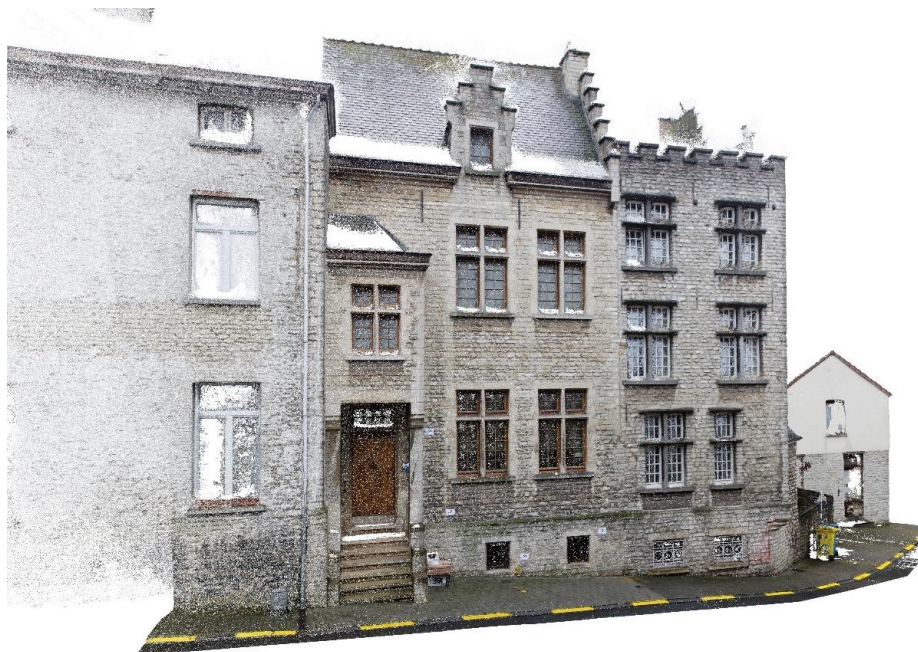
Figuur 12. Weergave van een 3D-scan van de voorgevel – zicht van links. (Afbeelding: WTCB)
