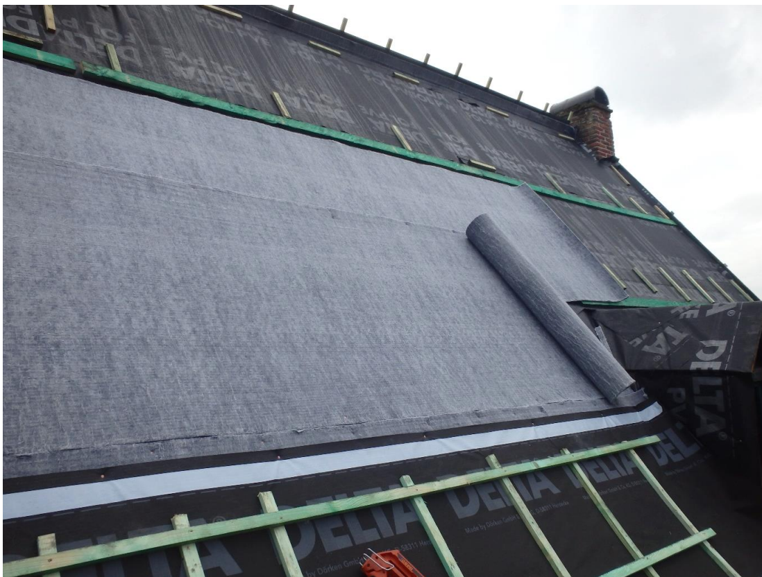
Figuur 57. Het afrollen en plaatsen van de twee lagen aerogeldekens in het vlak van het dak. Aan de randen zijn de dekens minimaal bevestigd met spijkers met brede koppen. Daarna worden ze geklemd onder de tengels en panlatten, die geschroefd worden in de onderliggende kepers. (foto: Dakwerken Gebroeders Van Loy)
