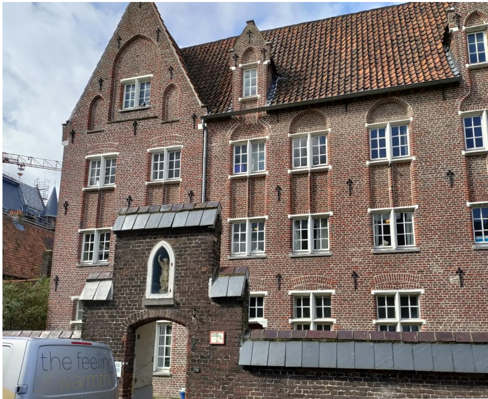
Figuur 165. Voorgevel van convent 85. (Foto: WTCB)
