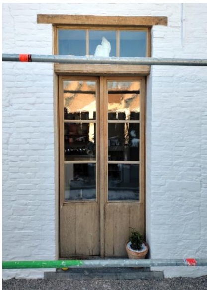
Figuur 37. Deurraam met driedelig bovenlicht in de achtergevel.(Foto: WTCB)
