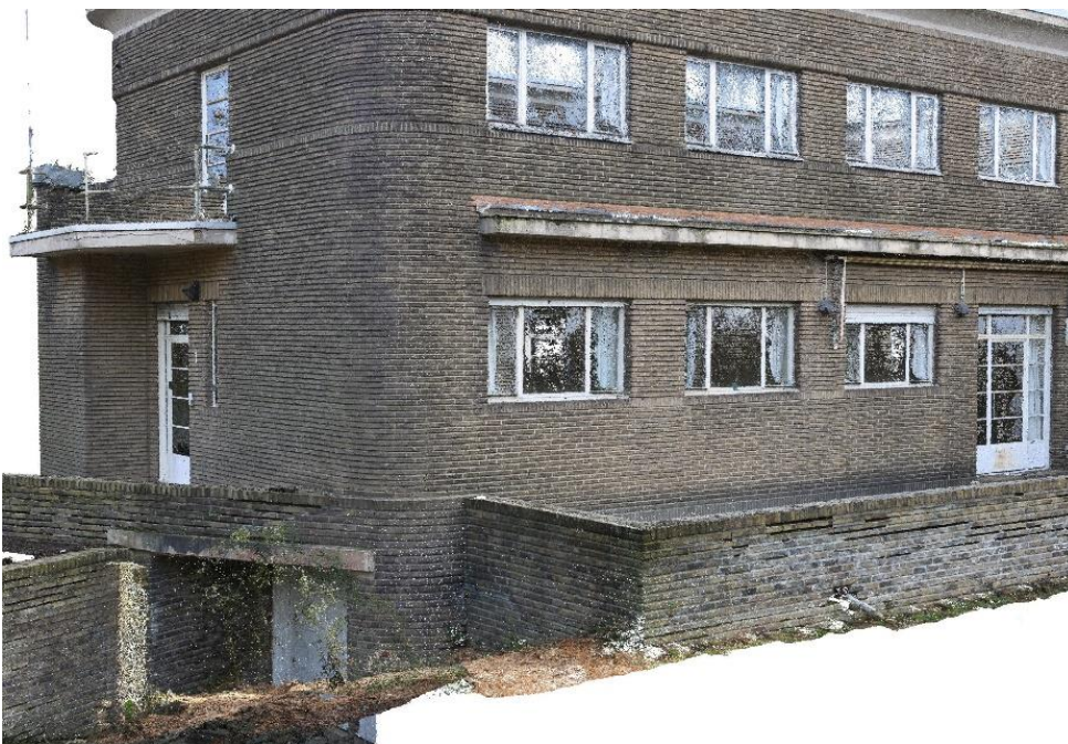
Figuur 72. Detail van de puntenwolk: zicht op de inkom en het terras. (©WTCB)
