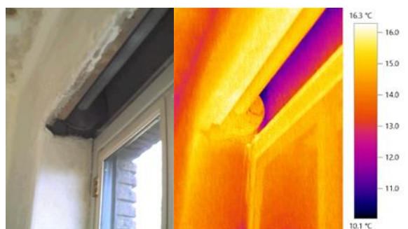
Figuur 78. Rolluikkasten tijdens de restauratie (16-02-2021) (©WTCB)
