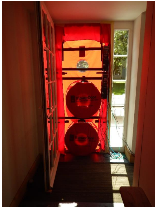
Figuur 103. Plaatsing van twee ventilatoren met gekoppelde regeling. (Foto: WTCB)
