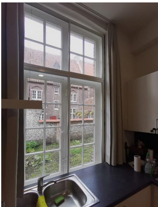
Figuur 174. Slanke aluminium schuiframen als nieuwe achterzetramen in convent 22 (Foto: WTCB).
