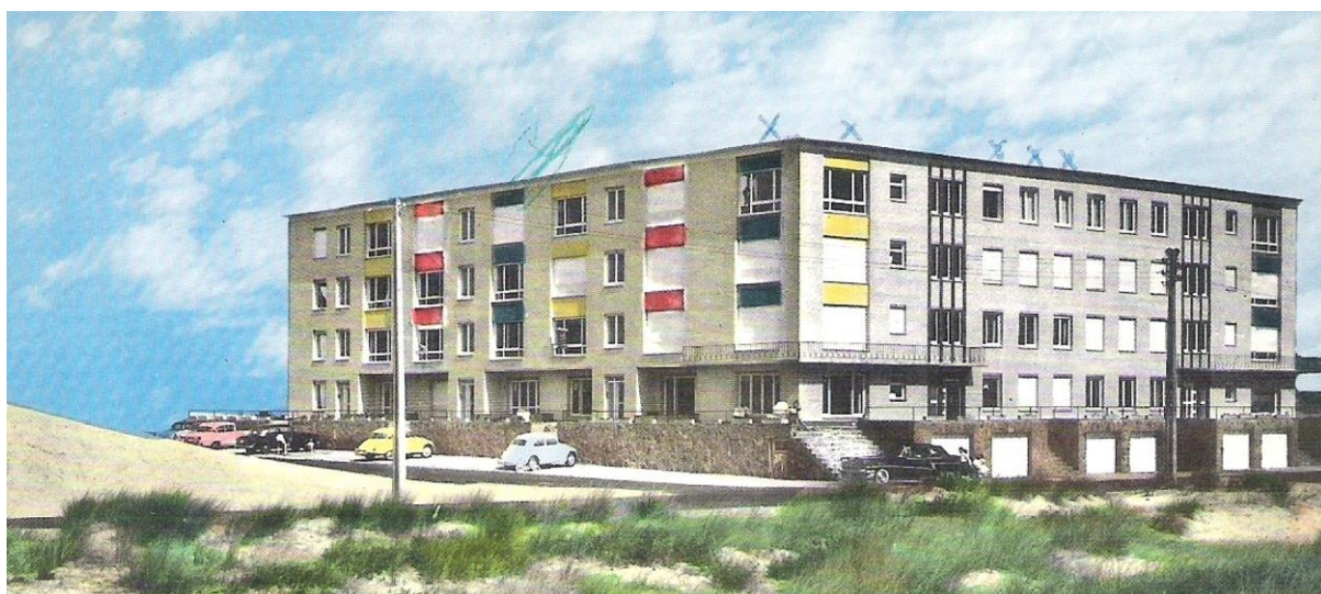
Figuur 183. Postkaart daterend van kort na de bouw, vermoedelijke jaren 1950. Hoek van de WWZ- en de ZZO-gevel. De gekleurde vlakken waren oorspronkelijk beschilderde pleister. Kort na de bouw werden ze echter bekleed met Glasal-panels omwille van vocht(- en mogelijk zout-)problemen. (Foto: WTCB)
