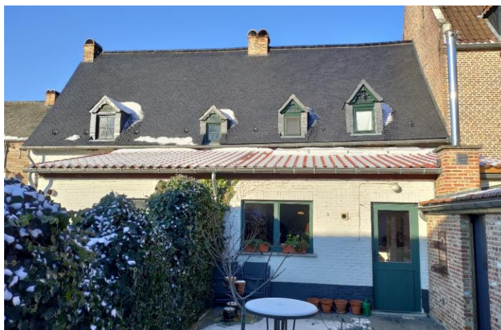
Figuur 55. Achtergevel van de beide woningen.(Foto: WTCB)
