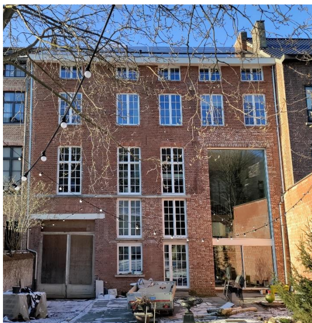
Figuur 89. De achtergevel na renovatie (2021). (Foto: WTCB)
