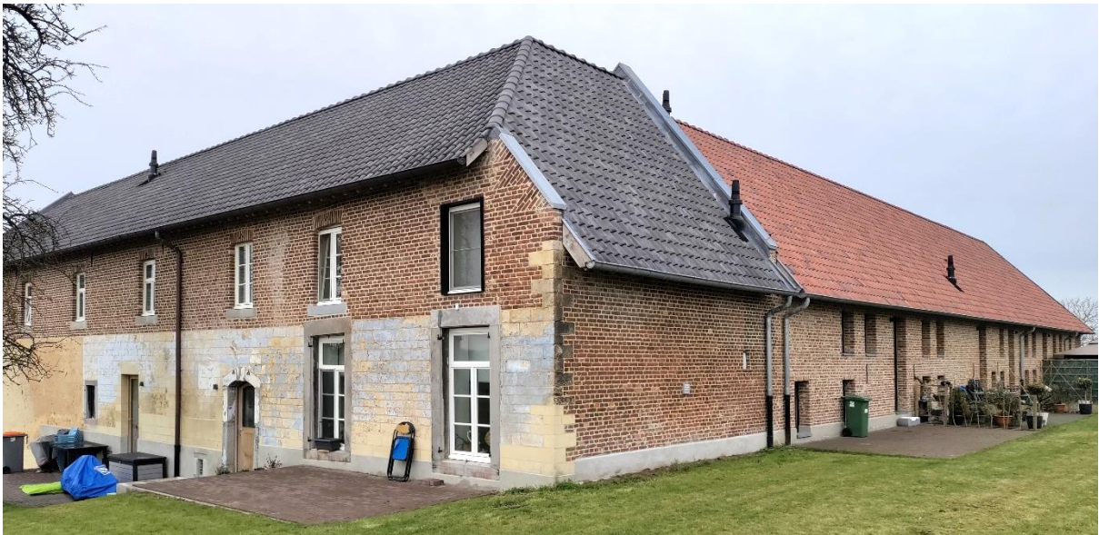
Figuur 117. Gevels van de beschouwde woningen aan de tuinzijde. De hoekwoning is woning 3 (in het oorspronkelijke woonhuis); links daarvan woning 2; rechts woningen 4, 5 en 6 (in de oorspronkelijke stallingen). (Foto: WTCB)
