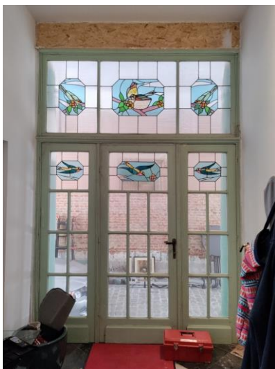
Figuur 95. Toegangsdeur in glas-in-lood (Foto: WTCB)
