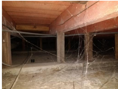
Figuur 10. De plankenvloer wordt gesteund door kleine stutjes die rusten op verdeelbalken op volle grond (of een uitvullaag).(Foto: WTCB)
