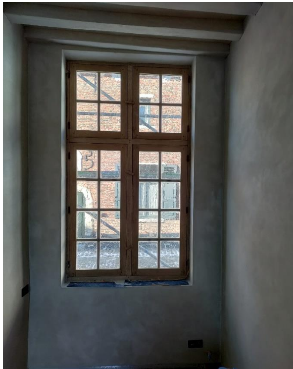
Figuur 35. Binnenzicht van het raam naast de voordeur.(Foto: WTCB)
