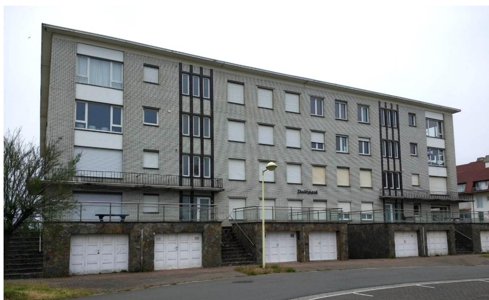
Figuur 184. ZZO-gevel in 2019, vóór de start van de renovatiewerkzaamheden. (Foto: WTCB)
