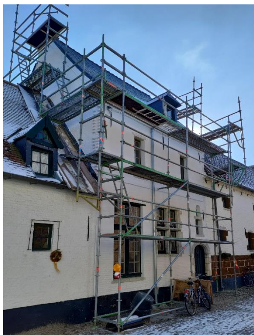
Figuur 32. Voorgevel (februari 2021).(Foto: WTCB)
