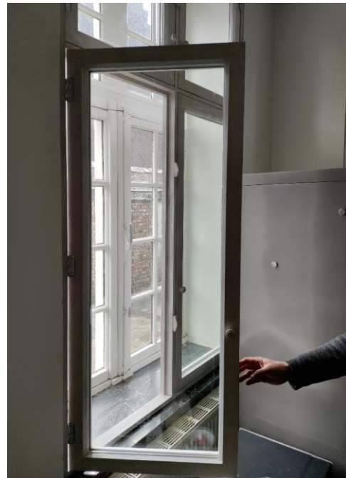
Figuur 173. Detail van een achterzetraam in het pauzelokaal van convent 85. Er is een slank kruisvormig vast kader met vier opengaande vleugels. De onderste regel is dun om het openen van het oorspronkelijke raam niet te hinderen. (Foto: WTCB)
