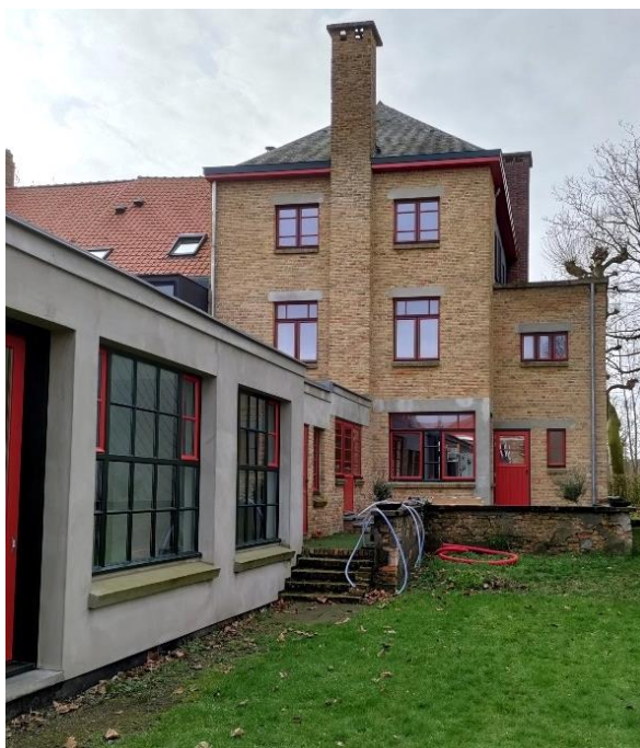
Figuur 139. Achtergevel, maart 2021. (Foto: WTCB)
