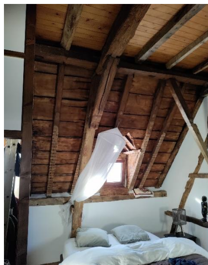
Figuur 56. Binnenaanzicht van het dak in de linkse woning, met zichtbare spant, gordingen, kepers en bebording. (Foto: WTCB)
