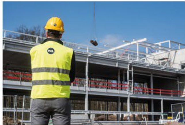
PXL BOUW EN ENERGIE
