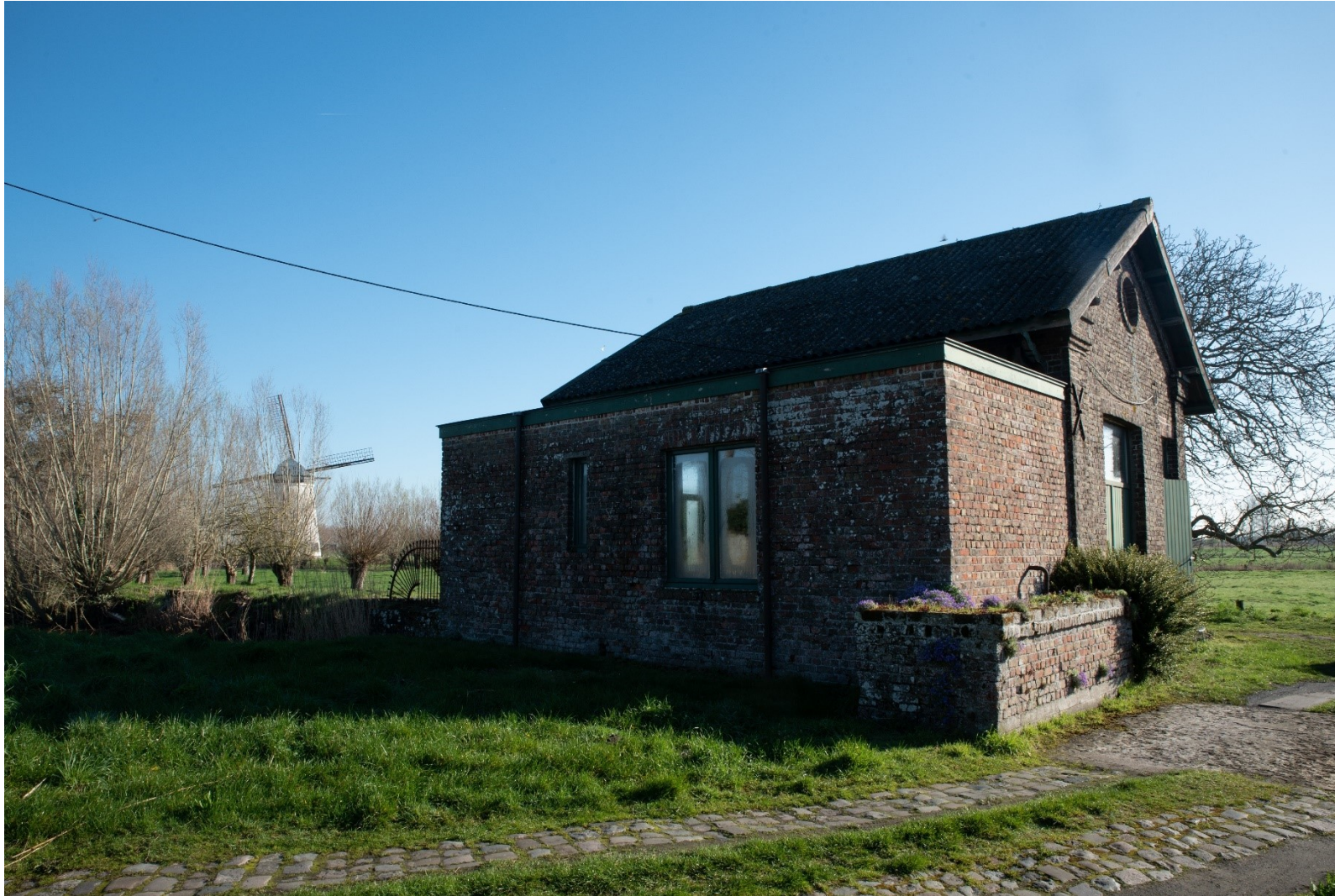
Figuur 3 Zicht op pompgemaal Meetkerke (Fotoarchief VLM, 2023)
