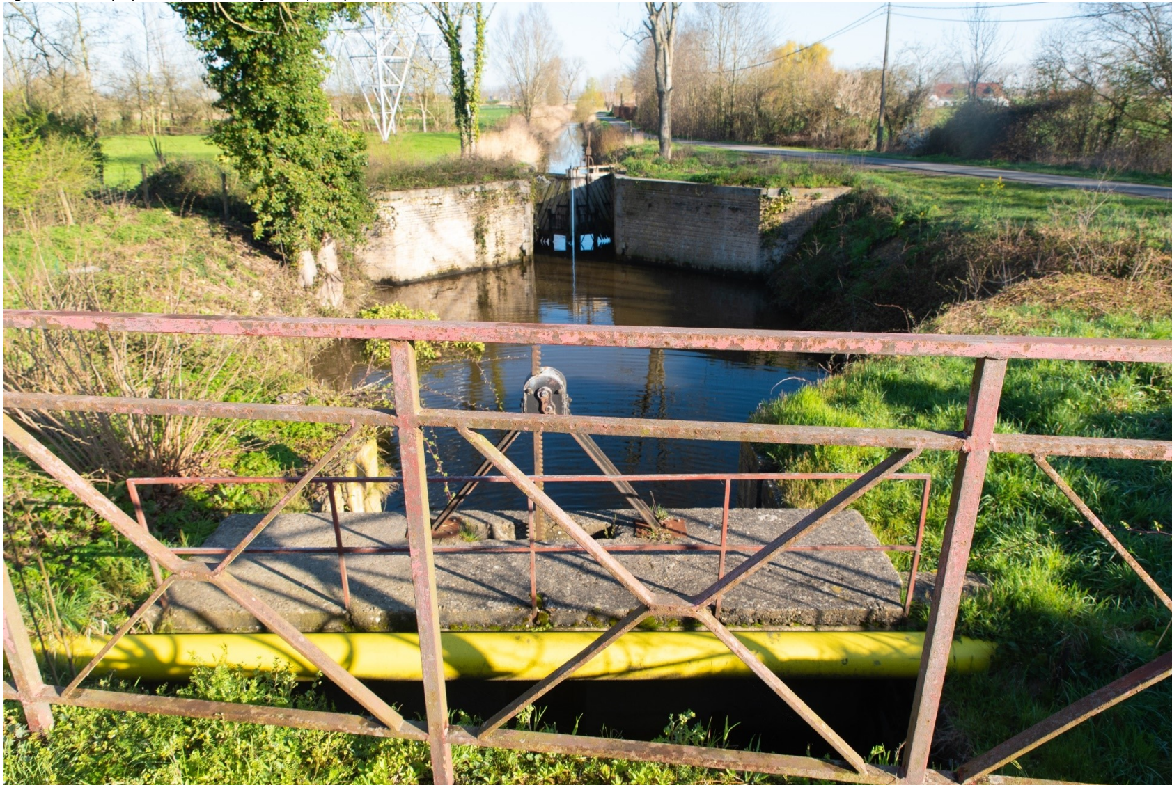
Figuur 2: Zicht op Speisluis, Fotoarchief VLM (2023).
