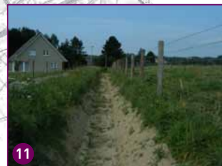
11 Heraanleg weg: buffergracht (augustus 2012)
