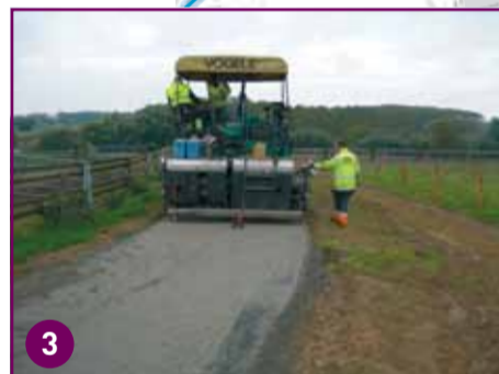
3 Heraanleg weg: toplaag (oktober 2012)
