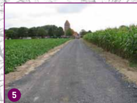
5 Aanleg fietspad: fundering (september 2012)
