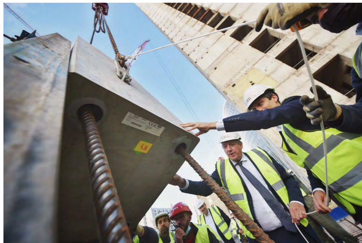
Eerstesteenlegging van het nieuwe kantoorgebouw Marie-Elisabeth Belpaire
