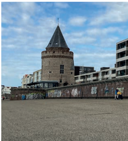
Fig. 19 Vlissingen. De overgebleven toren op de zeedijk. De andere toren was beschadigd door stormen en werd afgebroken.
