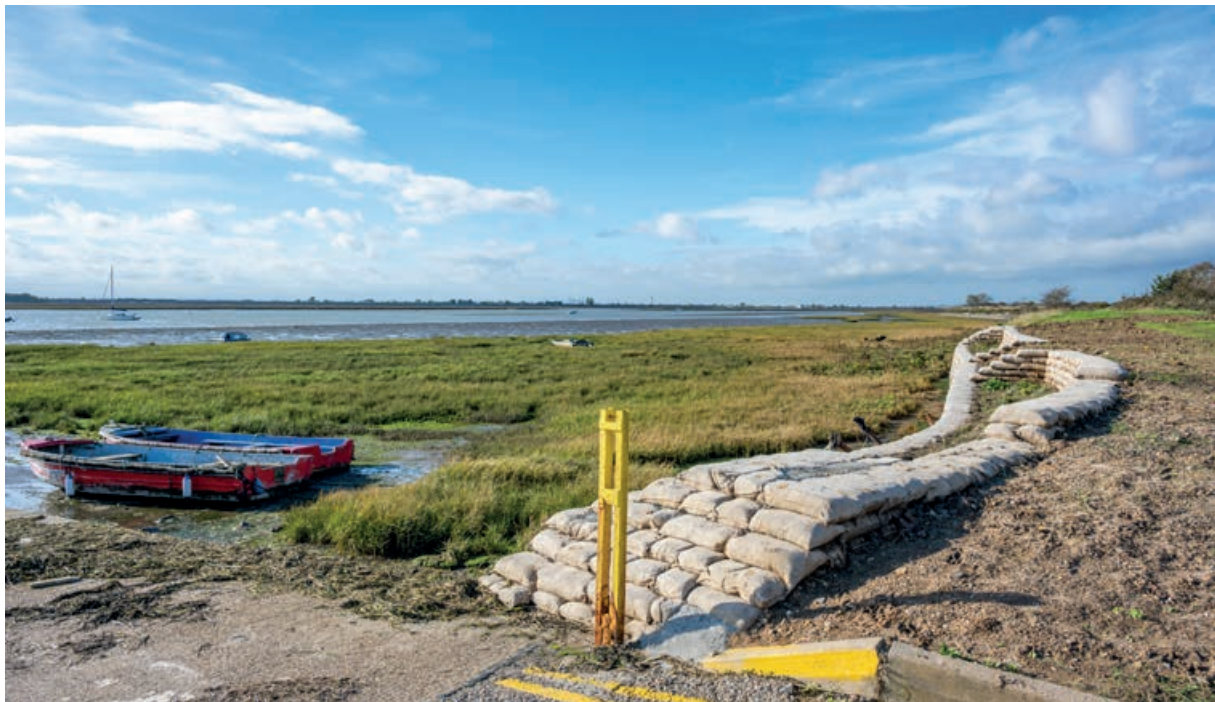
Two Tree Island. Een groene muur beschermt de kustlijn van het eiland tegen erosie.
