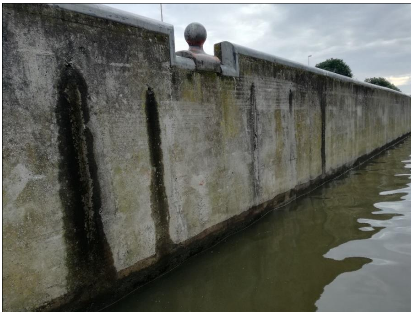
Foto 13. Kaaimuren ter hoogte van traject 11.
