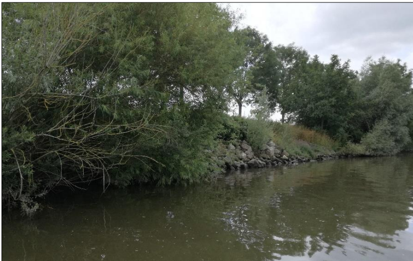
Foto 11. Oevers verstevigd met breukstenen ter hoogte van traject 17.
