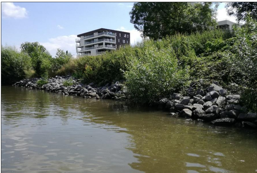
Foto 4. Oevers verstevigd met stortstenen ter hoogte van traject 14.
