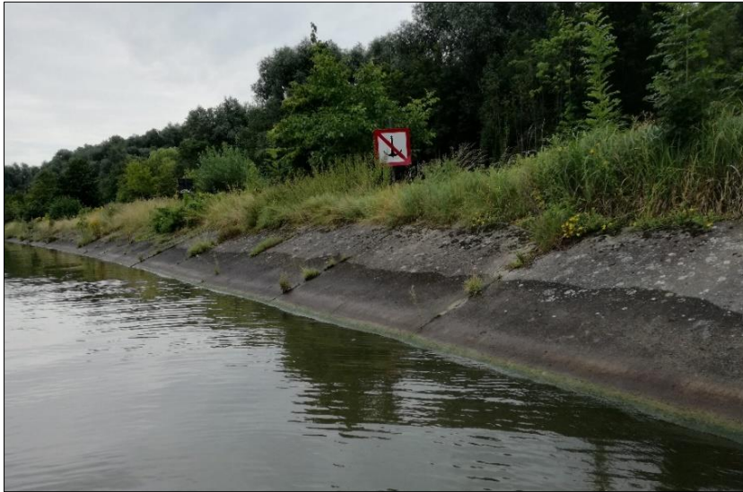
Foto 12. Verharde oevers met betonplaten ter hoogte van traject 1.
