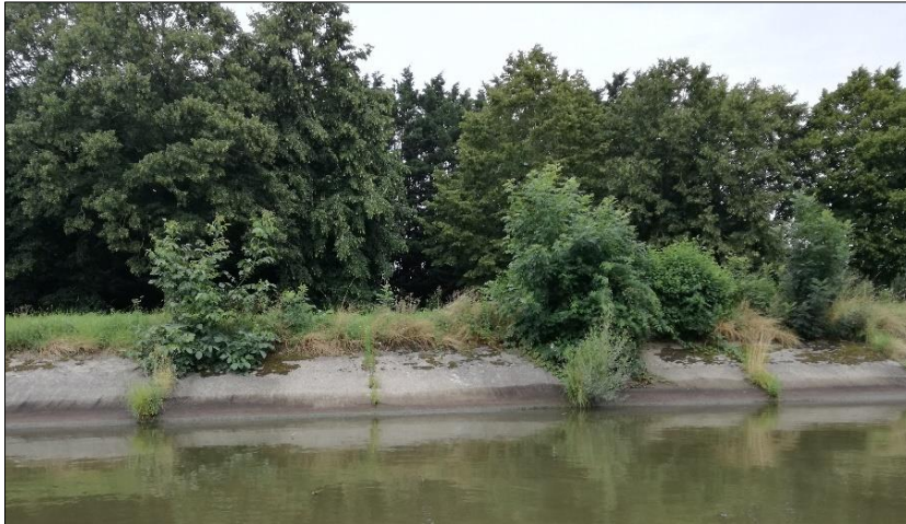
Foto 1. Betonoevers ter hoogte van traject 4.
