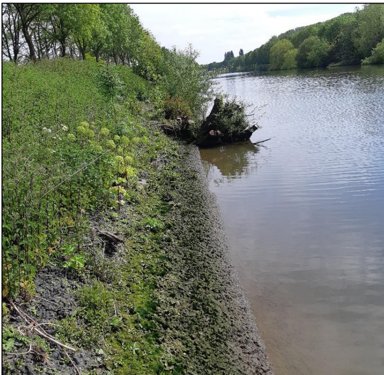
Foto 2. Oevers met steenafalt ter hoogte van traject 9.
