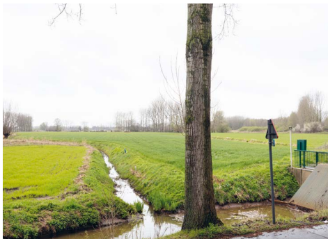
In het landschap vinden we grachten terug waarmee het grondwaterpeil gestuurd kan worden en het water afgevoerd wordt.
