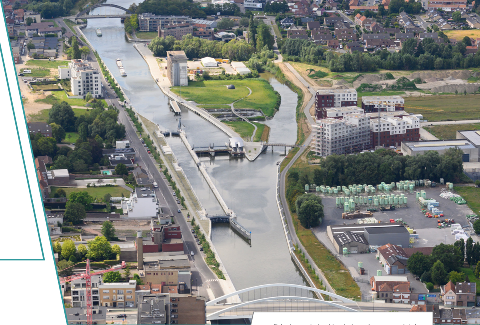
Sluis, stuw, waterkrachtcentrale en vispassage op de Leie te Harelbeke (© de Vlaamse Waterweg)
