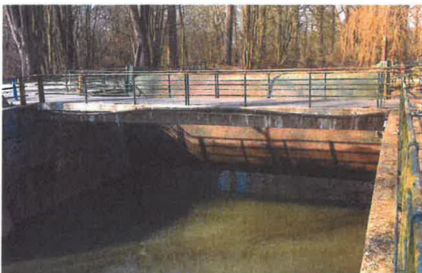
Foto 3: Opwaarts aanzicht radiaalschuif
