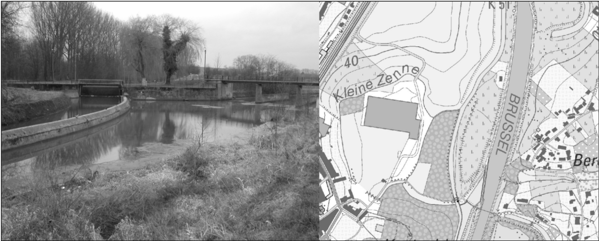
Figuur 5 – overlaat te Lembeek (Pereira, 2006)
