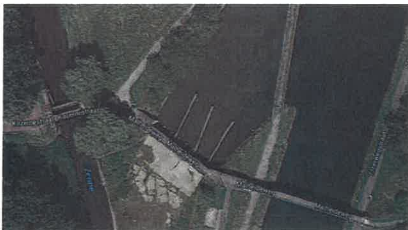
Foto1: bovenzicht radiaalschuif en overstormuurt (Kazernestraat, Lembeek)
