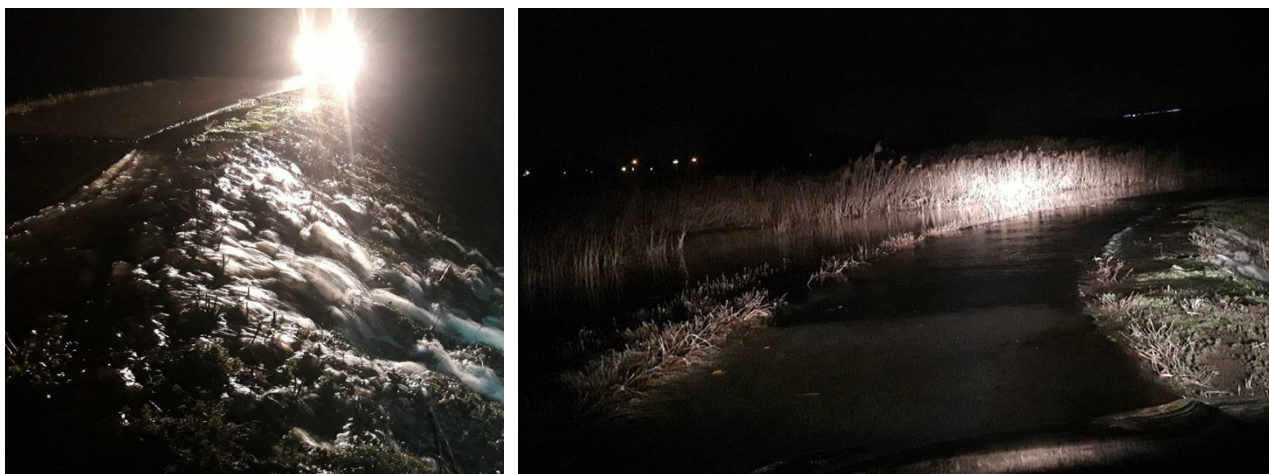
Figuur 19 – Overloop thv het Molsbroek (Pompstation Lokeren Afwaarts/Durme) in de nacht van 12-13 januari 2023 (Beelden: DVW)
