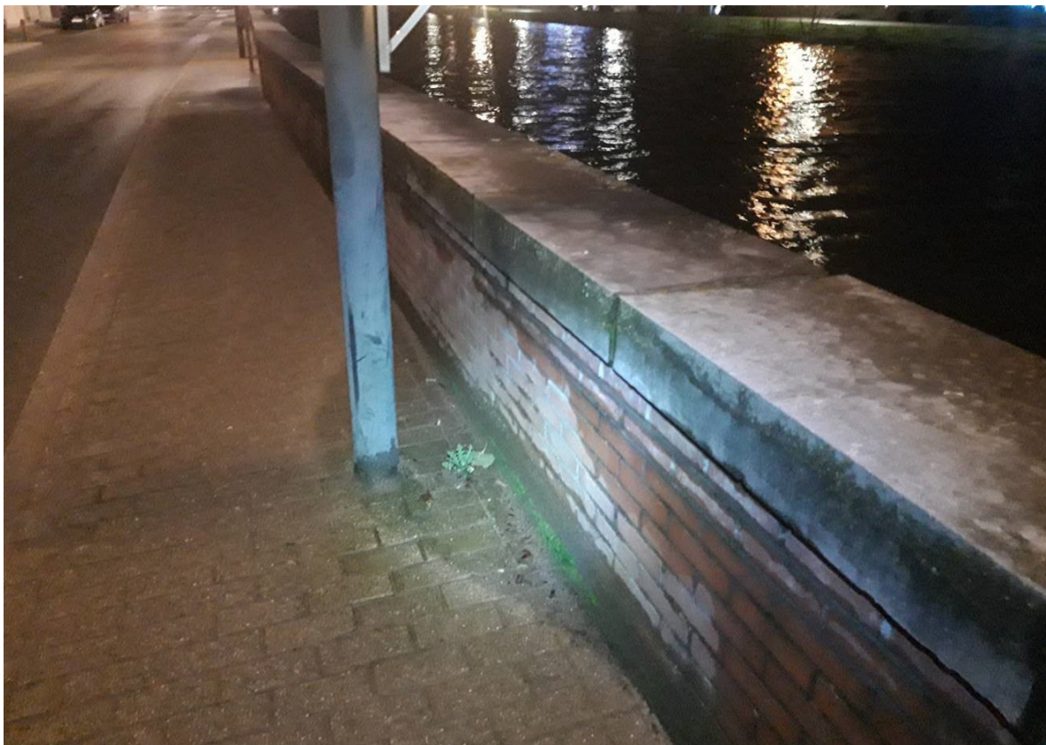
Figuur 18 – Beeld Centrum Lokeren rond maximaal peil Pompstation Opwaarts (nacht 12-13 januari 2023) (bron: DVW)
