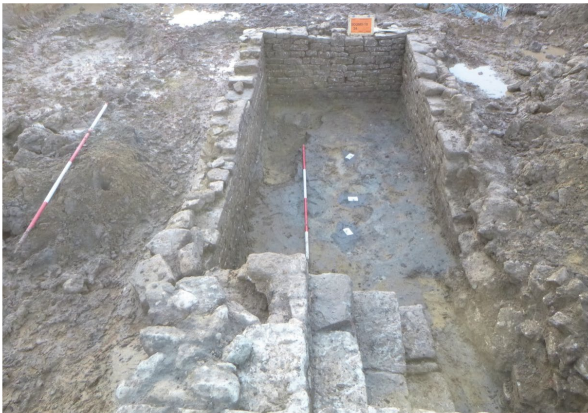
Fig. 5.22: Kerkom (Boutersem) - Kerkstraat: zicht op een van de natuurstenen kelders (© RAAP).
