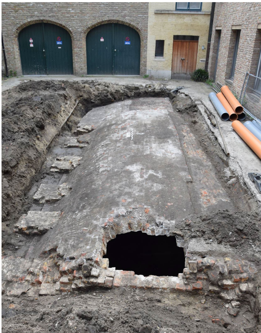
Fig. 5.39: Brugge - Rode-Haanstraat: de gewelven en contouren van de dubbele straatkelder (@agentschap Onroerend Erfgoed).
