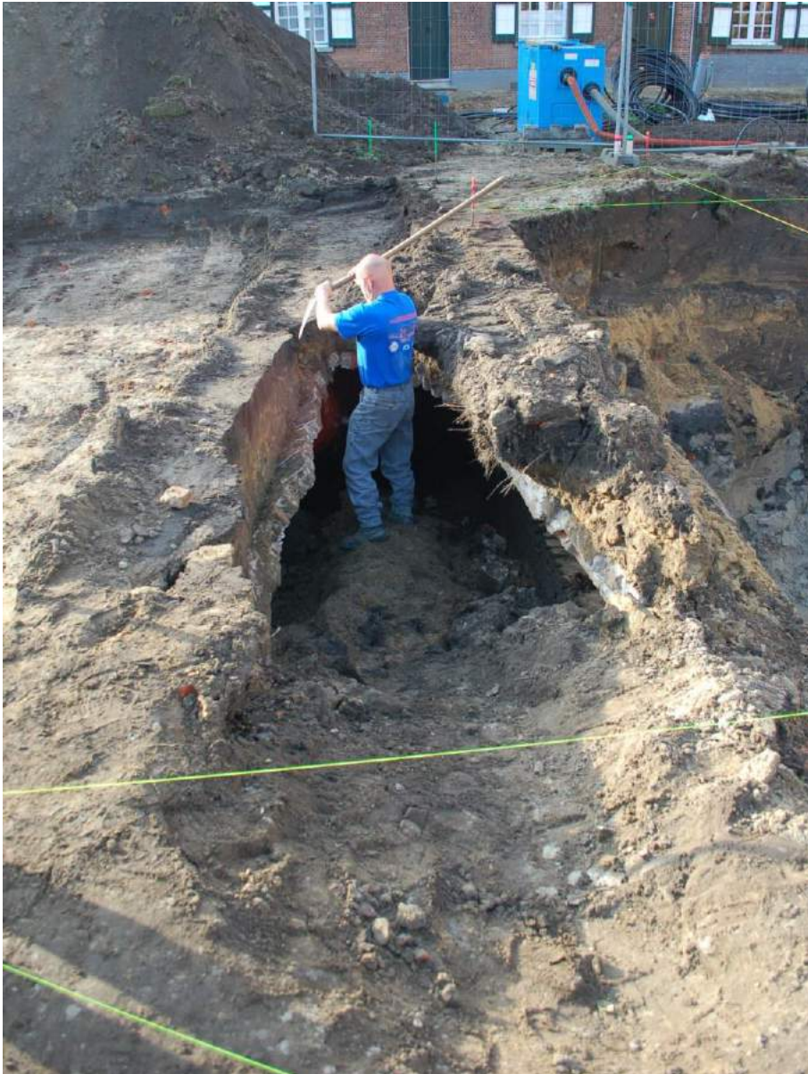
Figuur 11: Zicht vanuit het noorden op de ondergrondse structuur zoals deze bij aankomst werd aangetroffen. De noordzijde is grotendeels opgevuld met puin en sediment als gevolg van de instorting van het gewelf. Een profiel wordt aangelegd op de oostzijde van de rand van het gewelf. Van de toegangspuit aan de zuidzijde is bovenaan op de foto nauwelijks een rand van het arduinen deksel zichtbaar, aangezien de rest nog begraven is.
