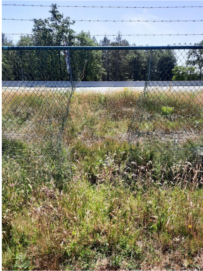
Figuur 30: Op sommige plaatsen is het raster volledig doorgeknipt, waardoor ook soorten als Ree op de snelweg kunnen terechtkomen (foto: Simon Feys, 17 juni 2022).
