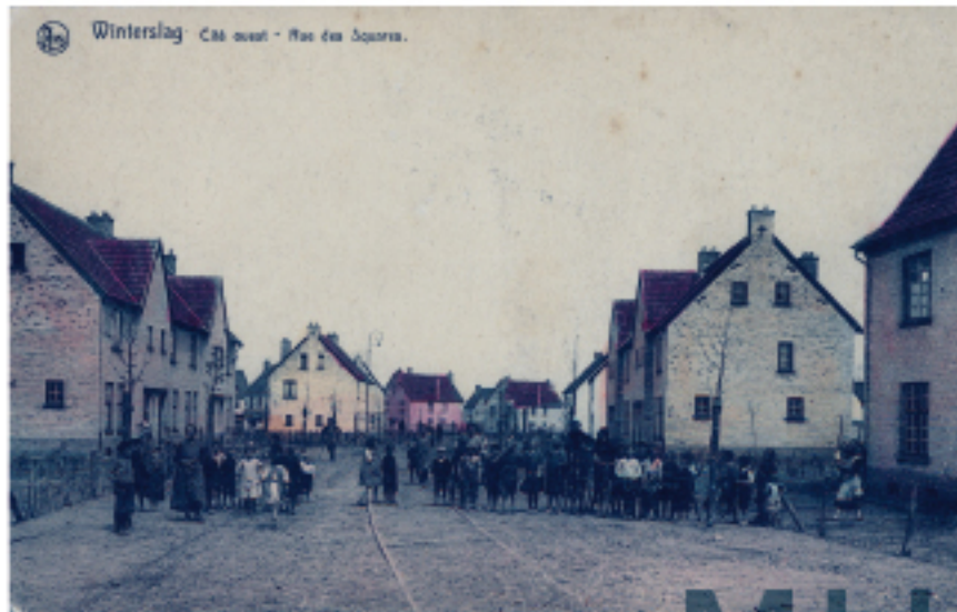
boven: Watershal, slaarwoningen vanaf 1910 naar ontwerp van J. Verschuier (Mijn-Kultur 1931-42-9; Presentiel; Streekl. Cultuur, nrd. 1910) onder: Tweende straat van Winterslag naar ontwerp van Adriaan Blaauw, jaren 1920 (Collectie Huisvesting Hobbelaars Groep)
