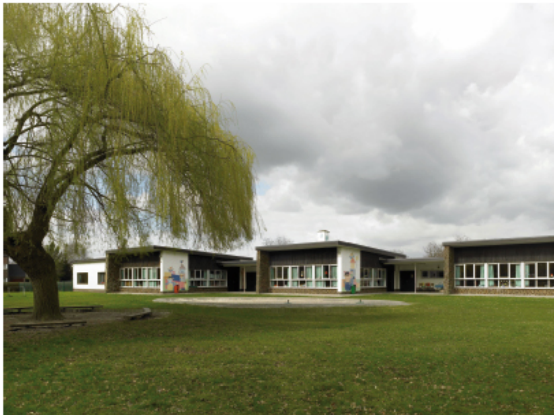
Klaarstechool gebouwd in 1954 door architect Hys Ingaur in opdracht van de re Koolmijnen van Zwaarberg (Mijn-Kultur, 4; Huisvesting)
