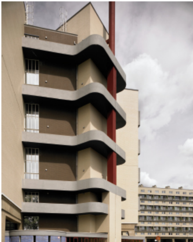
Het Kiel van Renaat Braem is een voorbeeldproject van kwalitatieve hoogbouw in het gras. In 1985 werd dit complex gerealiseerd door architectenbureau Vanhaste-Suls. Niet alleen de sanitaire installaties werden vervangen, ook de gevels werden met respect voor het ontwerp van Braem vernieuwd (2014 Vlaamse, 4 Vlaamse Gemeenschap).
