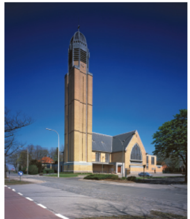
Paredkerk Christus-Koning in Genk uit 1935-36 van architect Voutquenne (Mijn-Kultur, 4; Huisvesting)
