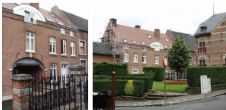
In 2008 werd de Klappel in Burgloon gerenoveerd tot 5 appartementen door architect Bernard de Schabten (VMSW).
