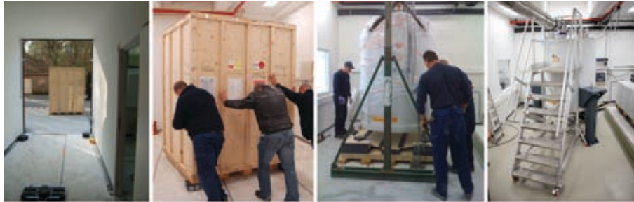
Figuur 2: Levering en installatie van de 800 MHz magneet in het Bio-NMR centrum aan het VUB
